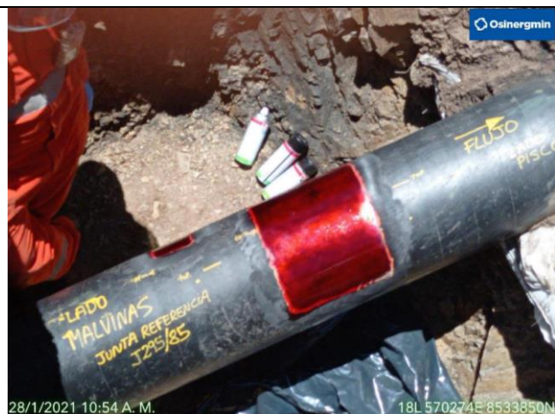
Figura 10: Aplicación de tintes penetrantes para inspección de integridad.
