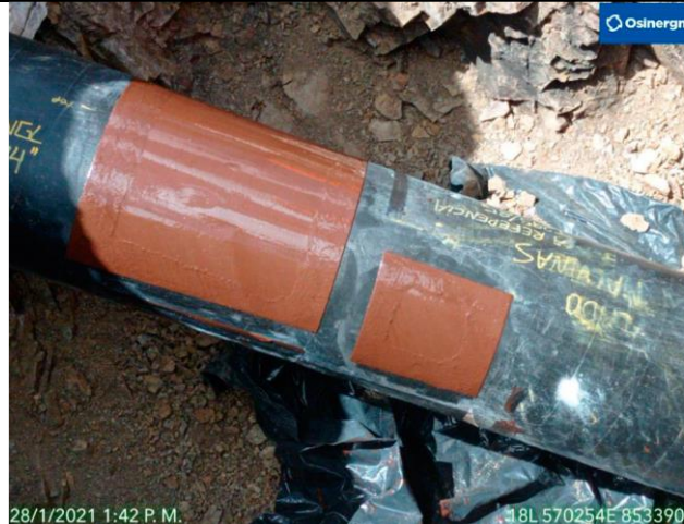
Figura 13: Vista final del recubrimiento epóxico sobre superficie reparada
