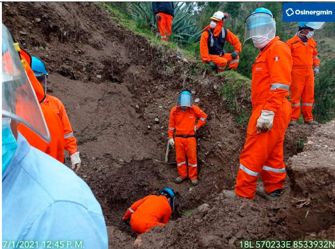
Figura 04: KP 314+020: Excavaciones para ubicación del punto de corte de la fibra óptica.
