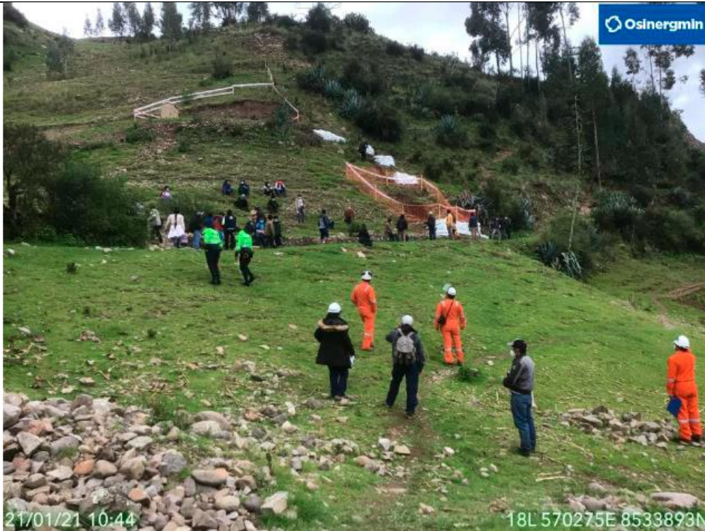
Figura 06: Anexo San Luis de Picha-C.C. Vinchos en el KP 314+000 donde se llevó a cabo la reunión a cargo del MINEM-OGGS-Ayacucho con autoridades de la comunidad e instituciones y representantes de la empresa TGP para obtener permiso de ejecución de trabajos.
