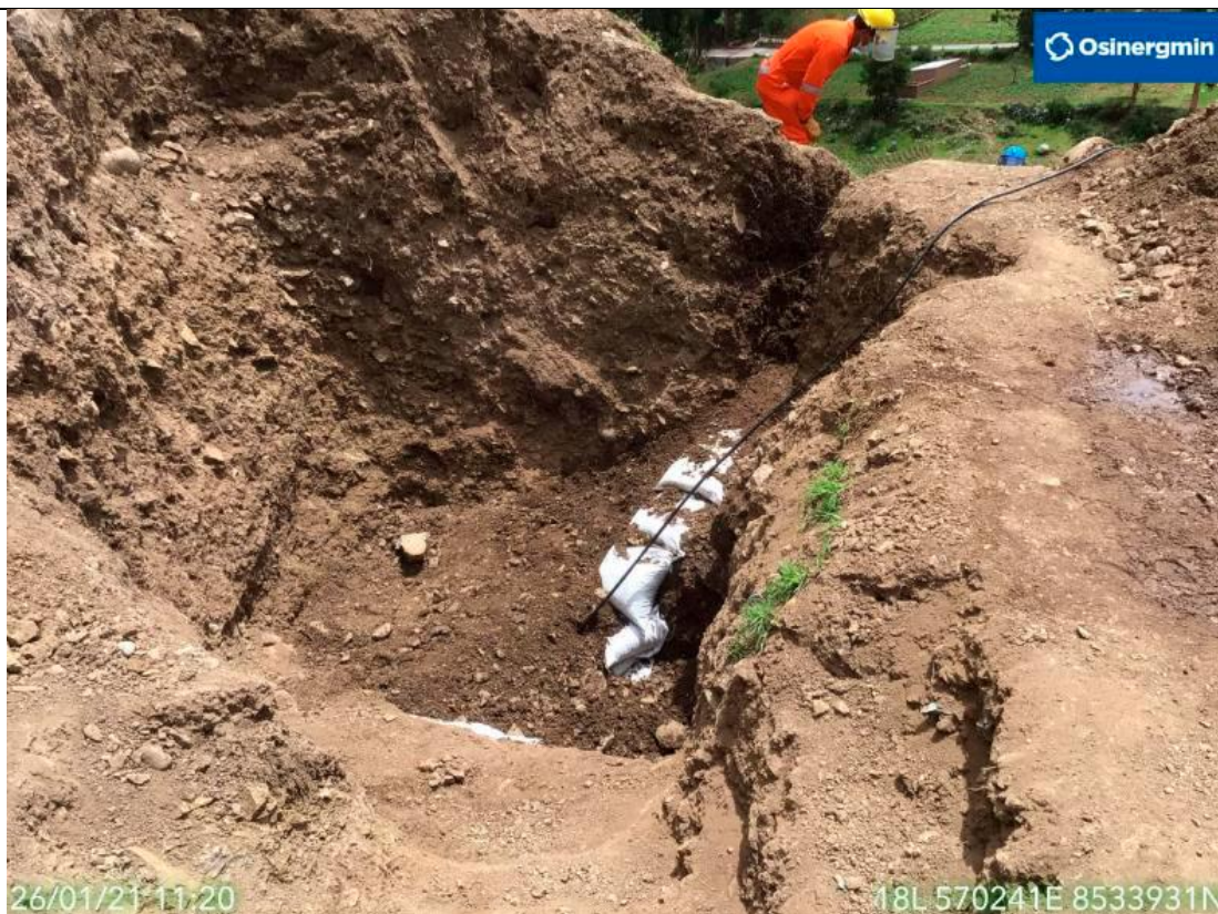
Figura 07: Se aprecian los trabajos de tapado de la segunda conexión del By Pass, ejecutados para recuperar la comunicación del STD.
