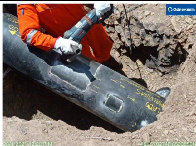
Figura 12: Esmerilado suave sobre los defectos
