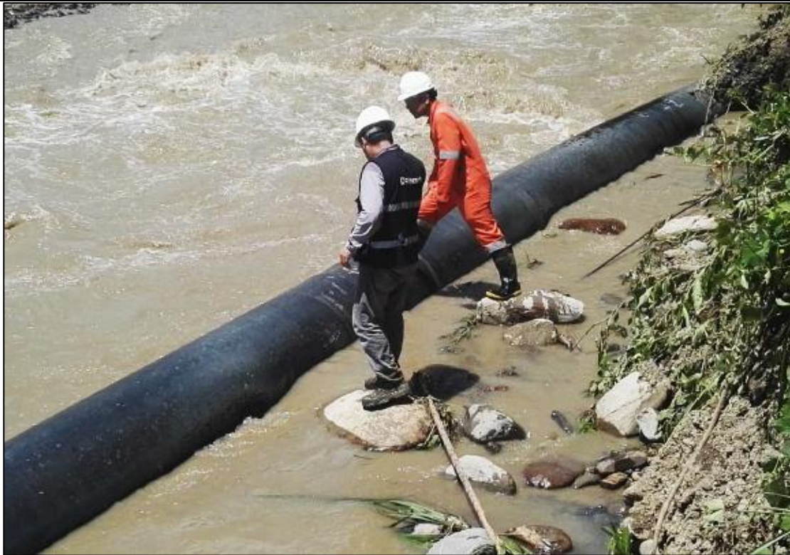
Figura 05: KP 091+521, inspección visual de la tubería expuesta, no evidenciando defectos significativos en el revestimiento.
