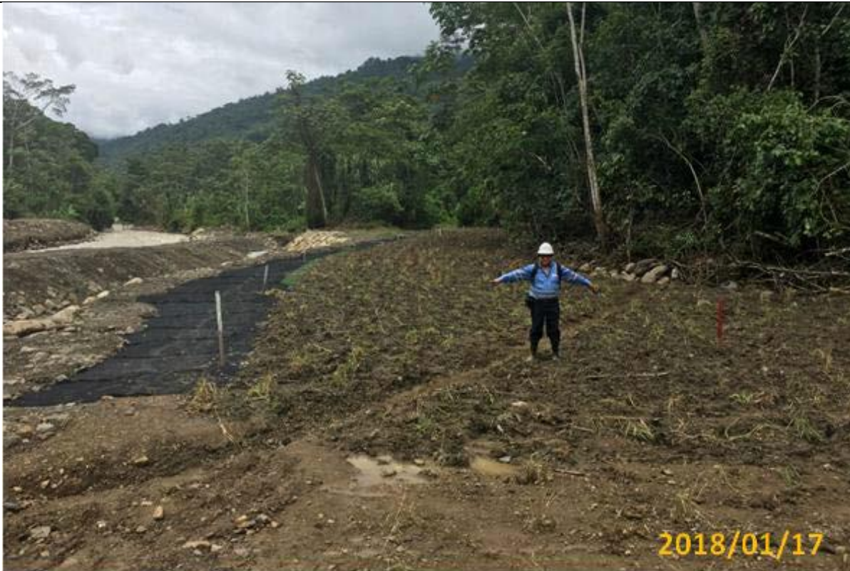
Figura 09: KP 091+521, Recomposición final de la zona erosionada.
