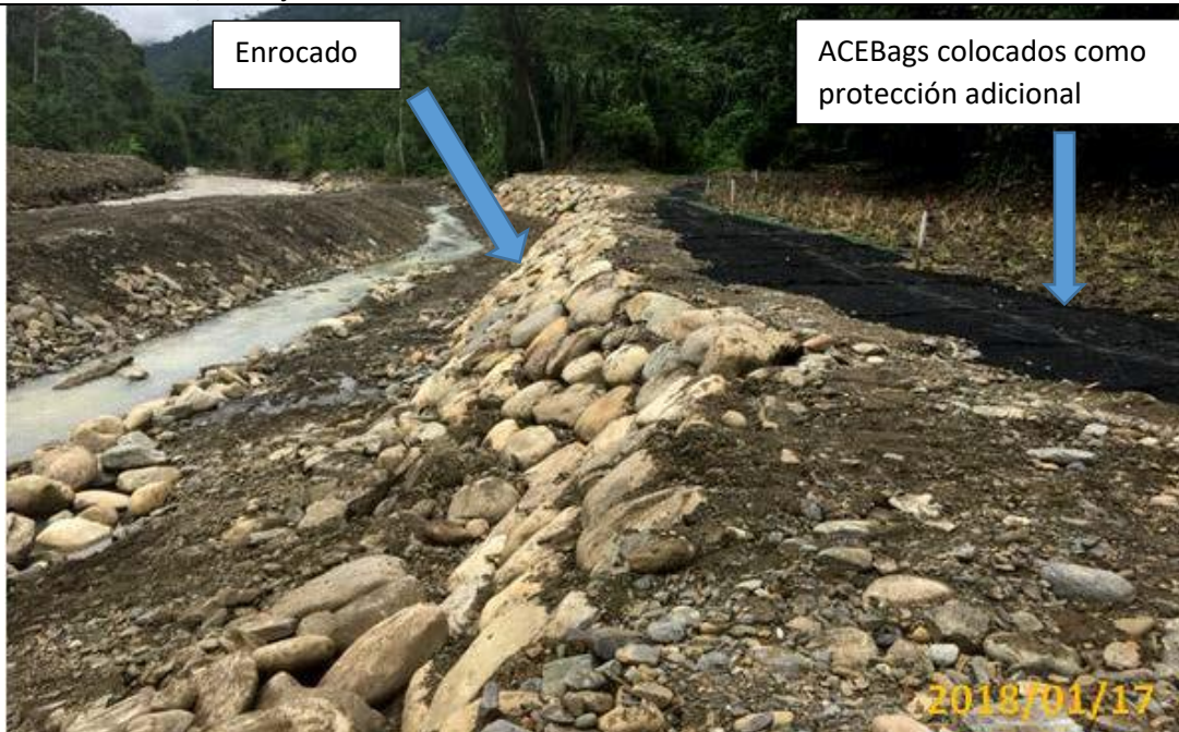
Figura 08: KP 091+521, Enrocado en la margen izquierda del río para protección del DDV y los ductos enterrados.
