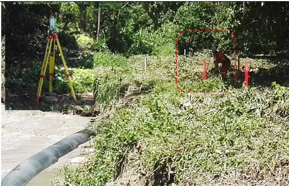
Figura 04: KP 091+521, Personal de TGP realizando actividades de topografía.
