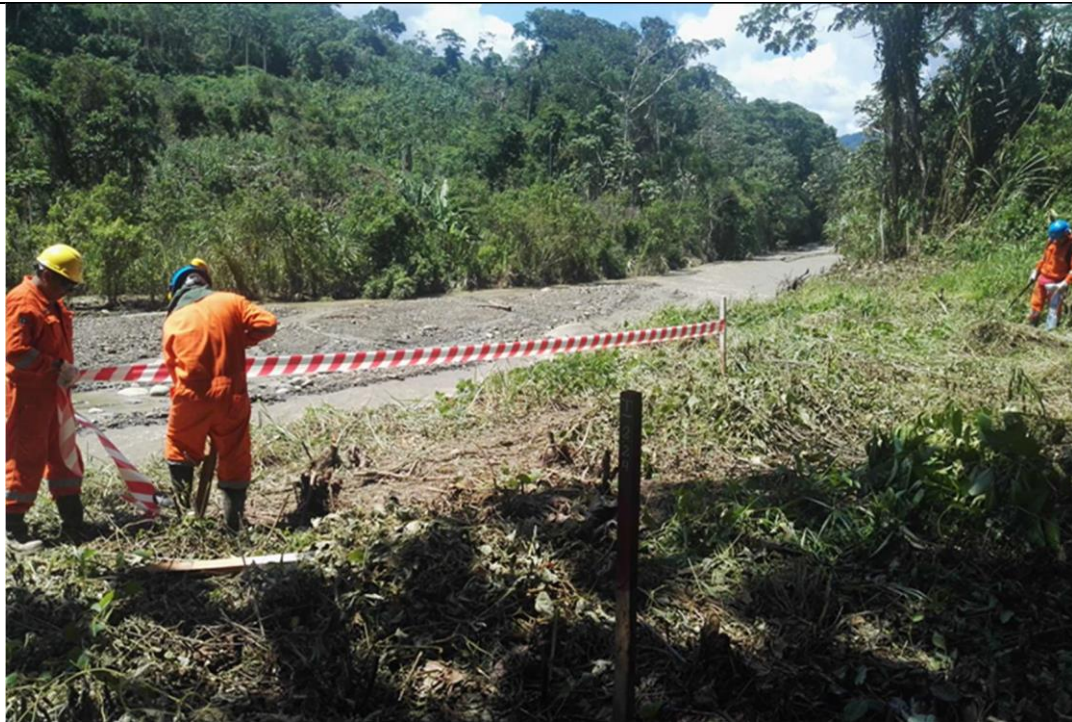
Figura 07: KP 091+521, Trabajos de señalización en la zona.
