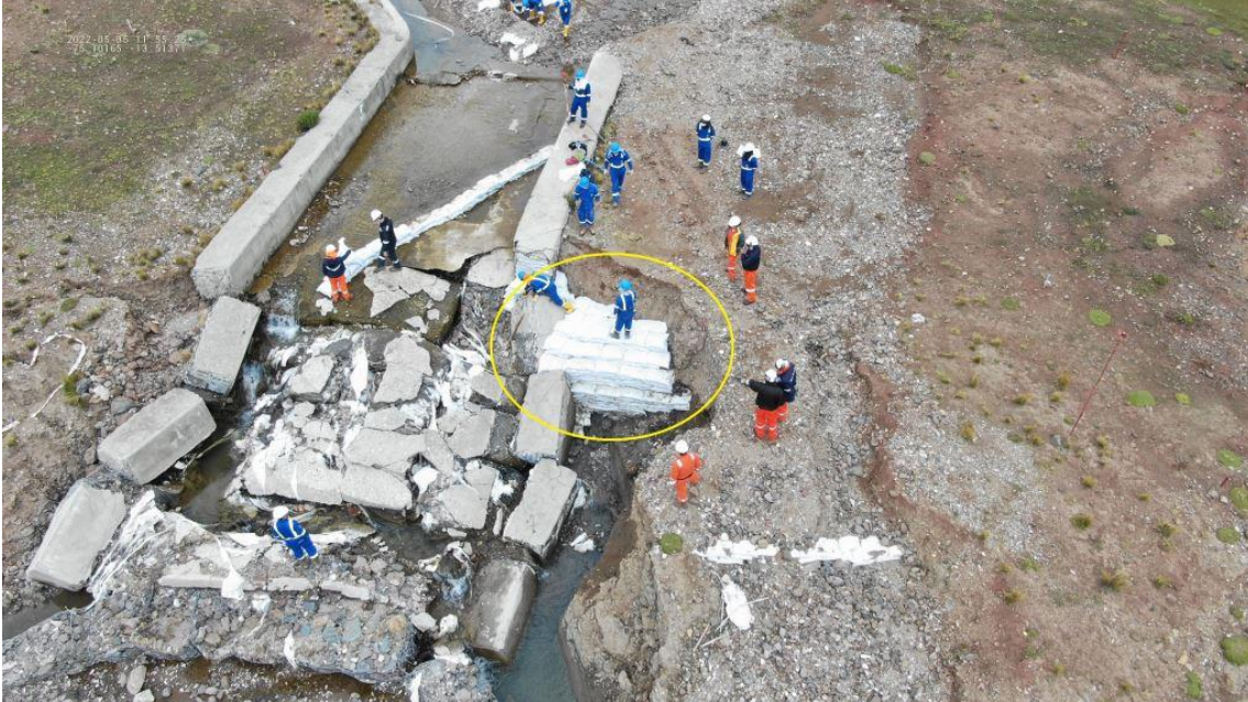
Figura 03: KP 415+085, acciones realizadas por el agente supervisado el día 05 de mayo de 2022, para la recuperación de tapada del ducto de NGL. Fuente: TGP
