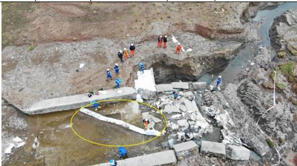
Figura 07: Sobre el ducto de LGN expuesto al medio ambiente se realizaron obras preventivas (Fuente: TGP)
