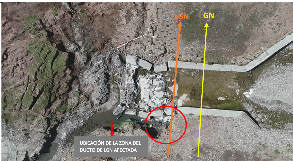
Figura 06: Vista panorámica de la zona, donde se aprecia el cruce de quebrada (KP 415+085) afectado por un deslizamiento adyacente al DDUV y con ello las obras implementadas por TGP fueron destruidas.
