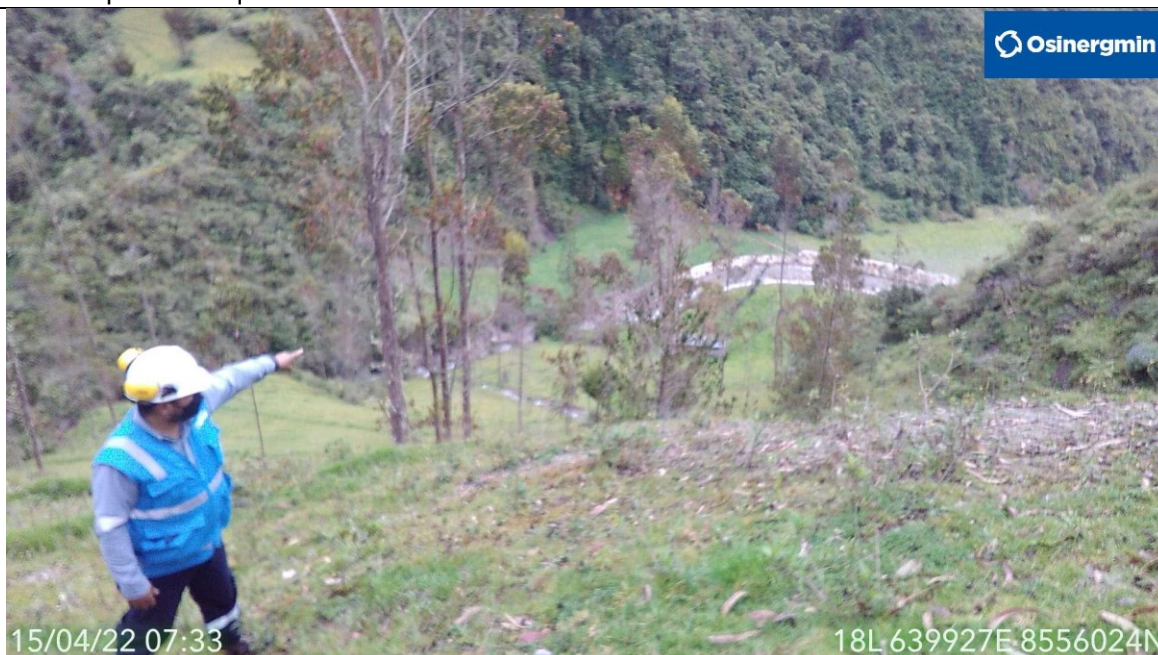
Figura 04: KP 211+550, se verificó que la zona donde se detectó la condición de riesgo se encuentra actualmente tapado y sin actividades de mitigación de riesgo.
