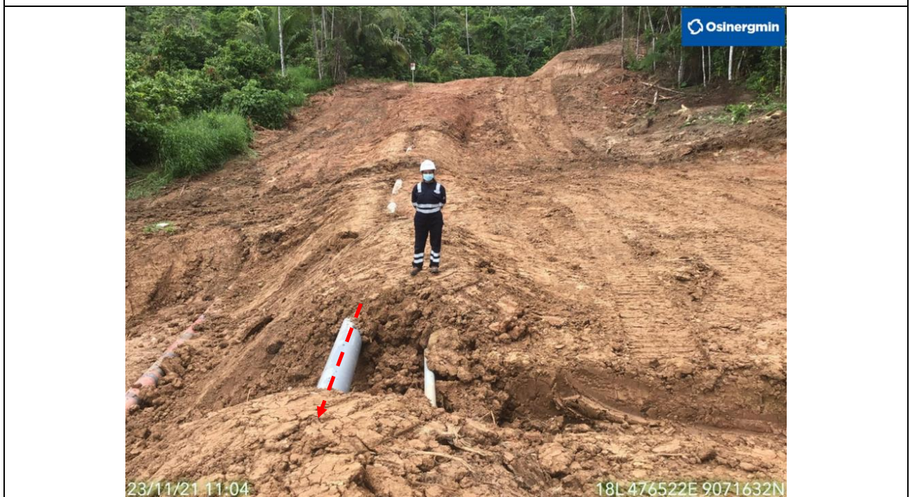
Figura 07: Detalle de la reubicación y reemplazo de los ductos de 12" GN y de 4" LGN que se encontraban tensionados a causa de un movimiento en masa
