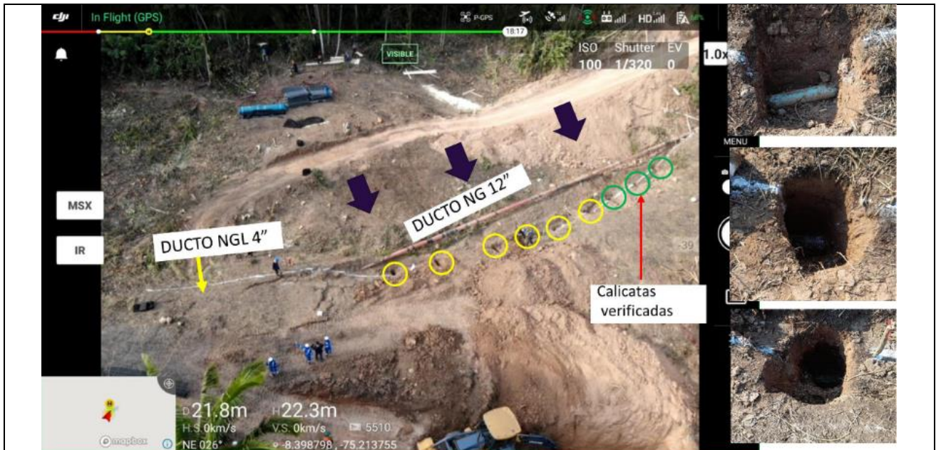
Figura 03: Vista aérea de la zona del KP 1+217.
