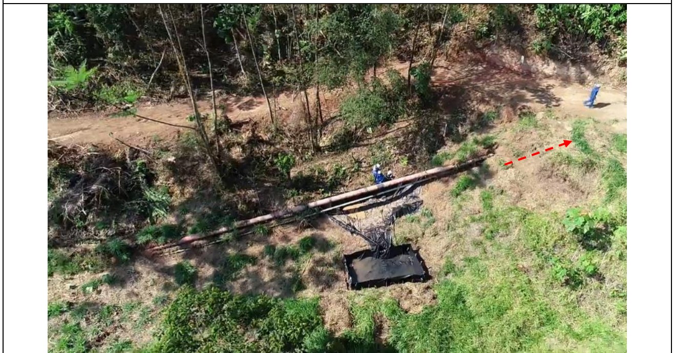
Figura 05: Vista panorámica de la condición de riesgo a la altura del KP 001+270, tomada desde un dron (RPAS) el 30/09/2021, en el cual se aprecia la exposición de los ductos de GN y LGN y la instalación de una poza como prevención ante posible derrame de LGN.
