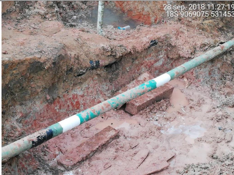
Figura 05: KP 77+800, Vista del Ducto LGN luego de los trabajos de reparación
