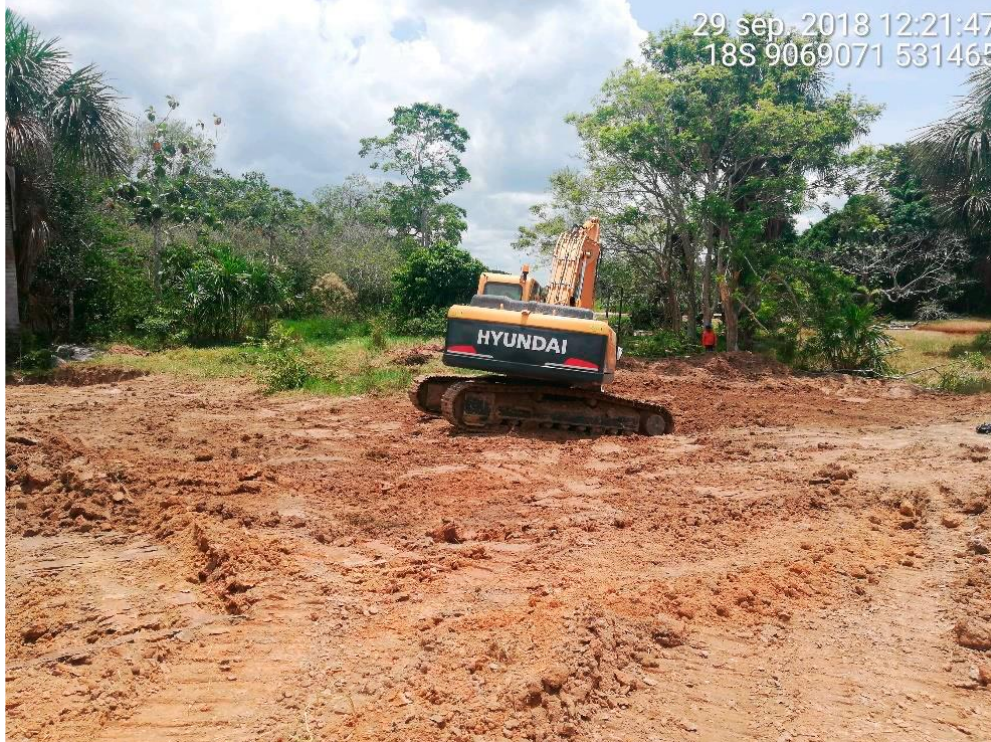
Figura 06: KP 77+800 – Trabajos de tapada y recomposición de la zona afecta.
