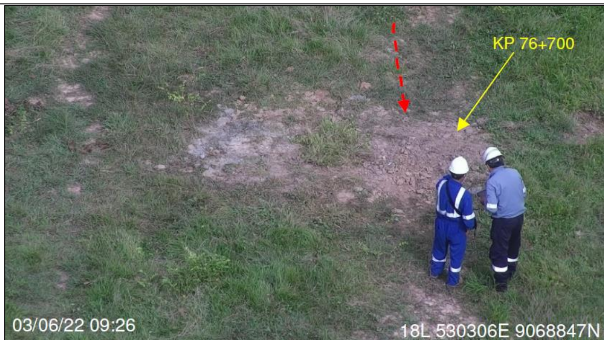
Figura 11: Imagen obtenida por Dron, Detalle en KP 76+700 (EN-PF), nótese la zona de condición de riesgo (IR-0001-2022), la válvula clandestina fue cubierta con mortero y luego se realizó la recuperación de tapada, como seguridad de manipulación por terceros.
