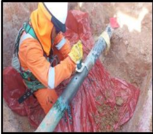
Figura 06: Delimitación y preparación de la superficie del KP 76+700.
