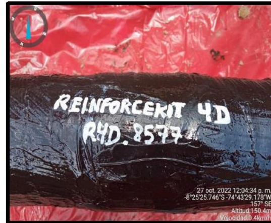
Figura 08: Colocación e impregnación de la cinta kevlar en el KP 76+700.
