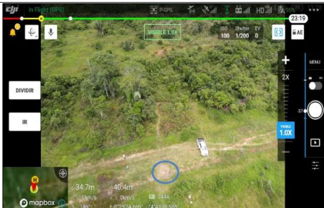
Figura 05: Vista del KP 76+700, captura fotográfica tomada mediante dron.
