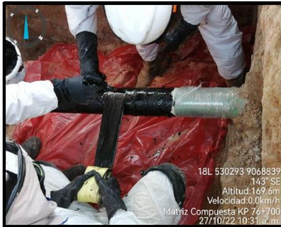
Figura 08: Colocación e impregnación de la cinta kevlar en el KP 76+700.
