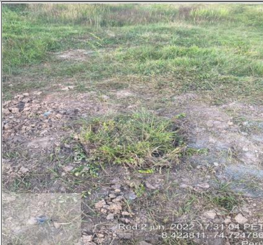
Figura 02: Vista de la condición de riesgo a la altura de la progresiva KP 76+700 del tramo Estación Neshuya – Planta Fraccionamiento.
