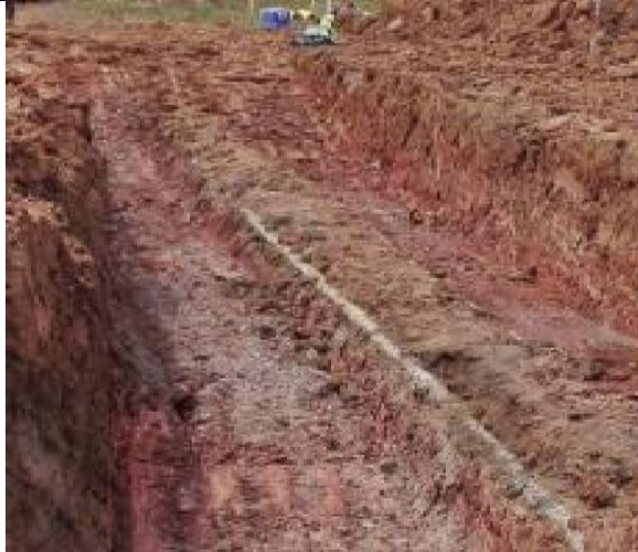
Figura 02: Vista después de la actividad de excavación profunda. Fuente: AEP.
