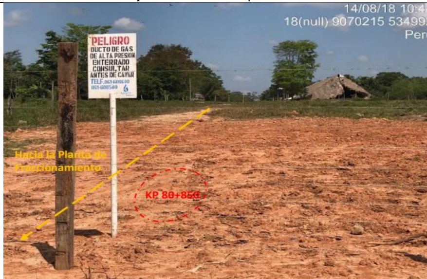
Figura N° 10: Vista del área de la condición de riesgo del KP 80+850 del Ducto de Transporte de LGN - Tramo Neshuya-Planta de Fraccionamiento.
