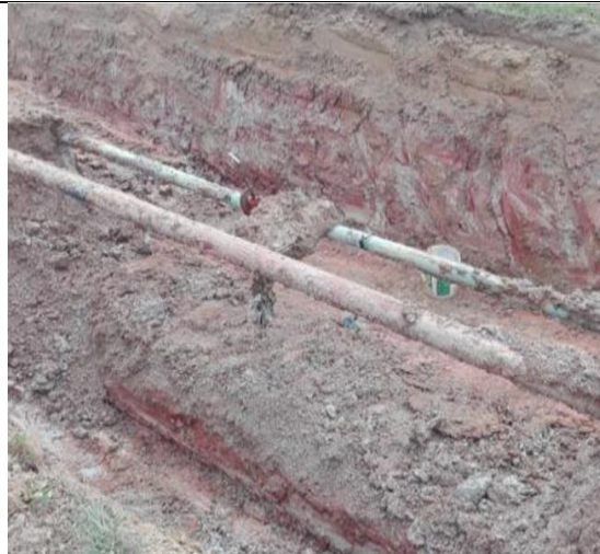
Figura 03: Vista después de la actividad de corte en frío. Fuente: AEP
