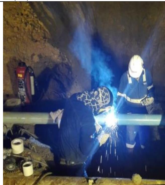
Figura 05: Vista de la actividad de soldeo de cordones. Fuente: AEP
