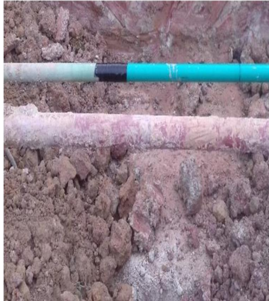
Figura 06: Vista después de la actividad de revestimiento de cordones. Fuente: AEP
