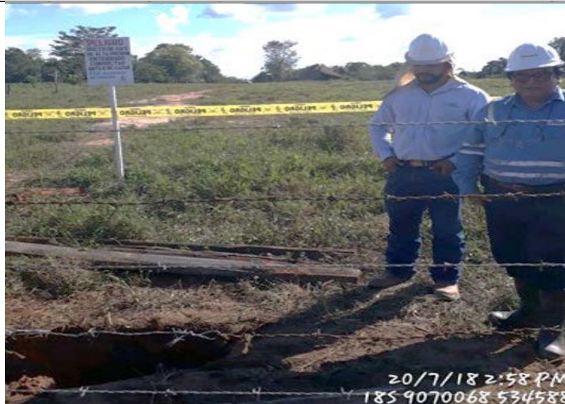
Figura 08: Vista del Supervisor de Osinerghmin y representante de AEP en la zona donde ocurrió la condición de riesgo.
