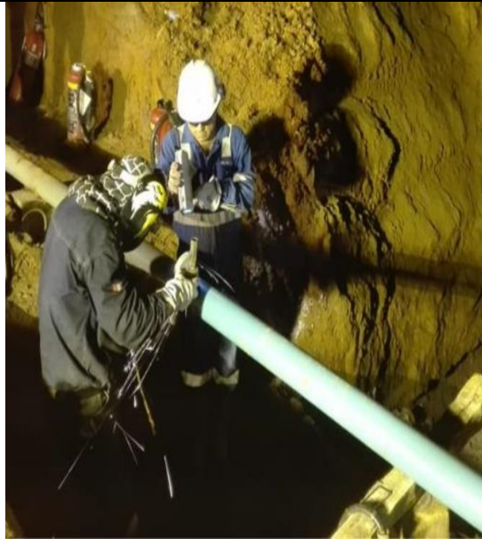
Figura 04: Vista de la actividad de preparación del bisel. Fuente: AEP
