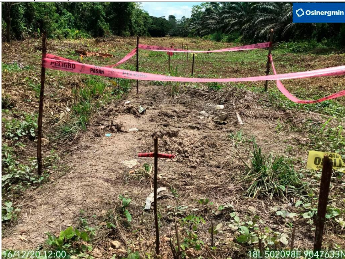
Figura 04: KP 38+250: Delimitación del área afectada donde se produjo la condición de riesgo debido a la extracción clandestina de LGN.
