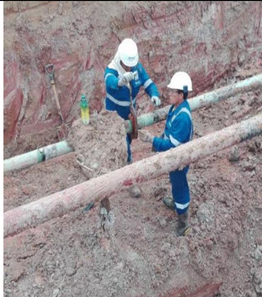
Figura 04: Vista de la actividad de corte en frío.
