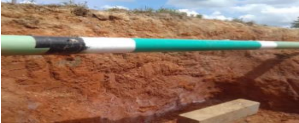
Figura 06: Vista después de la actividad de revestimiento de cordones.
