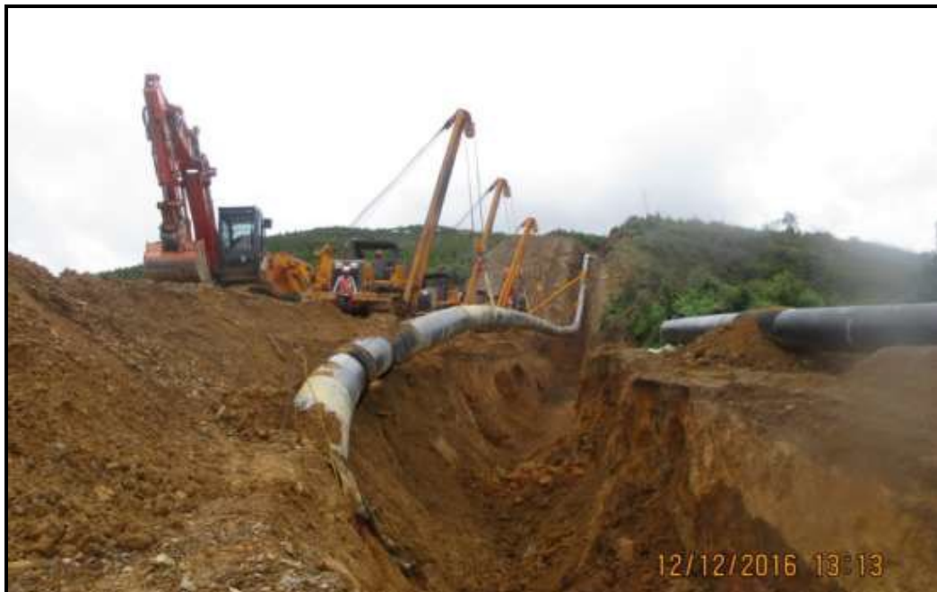
Tramo A1-Segmento 04, KP-0148+552 Vista general en la actividad de bajado en la parte final de la lingada
