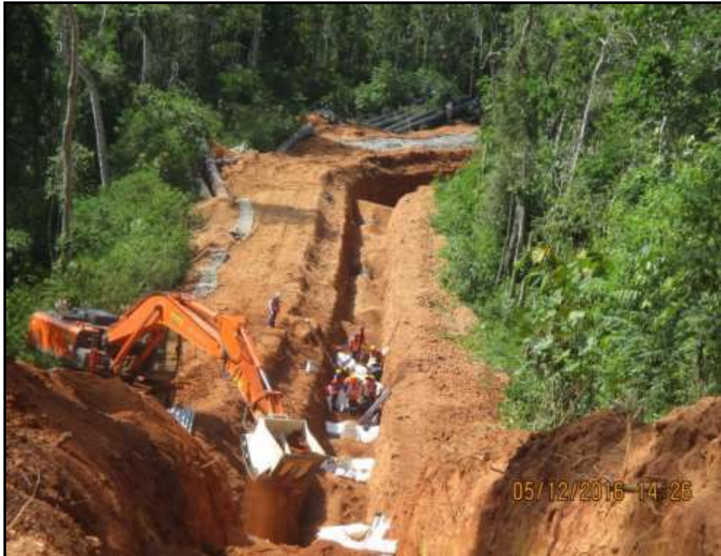
Tramo A1-Segmento 03, KP-0088+456 Vista del proceso de pre-tapado.
