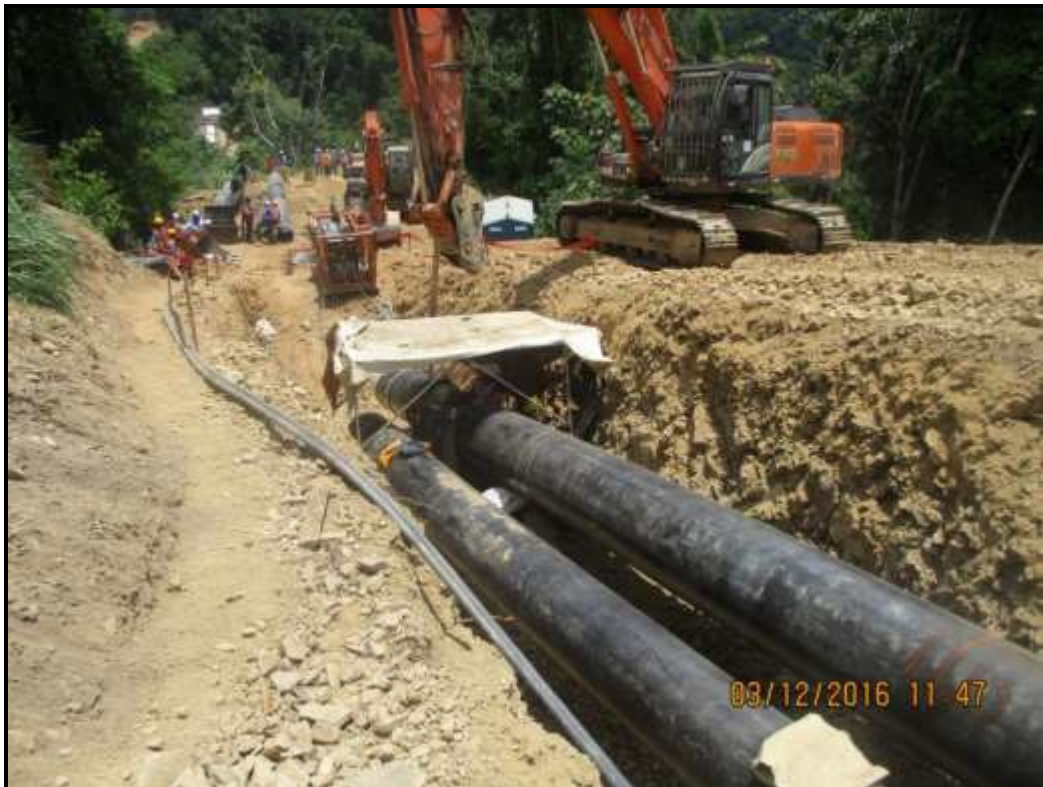
Tramo B-Segmento 02 KP-0076+552 Vista general en el proceso de soldadura en el KP 76.
