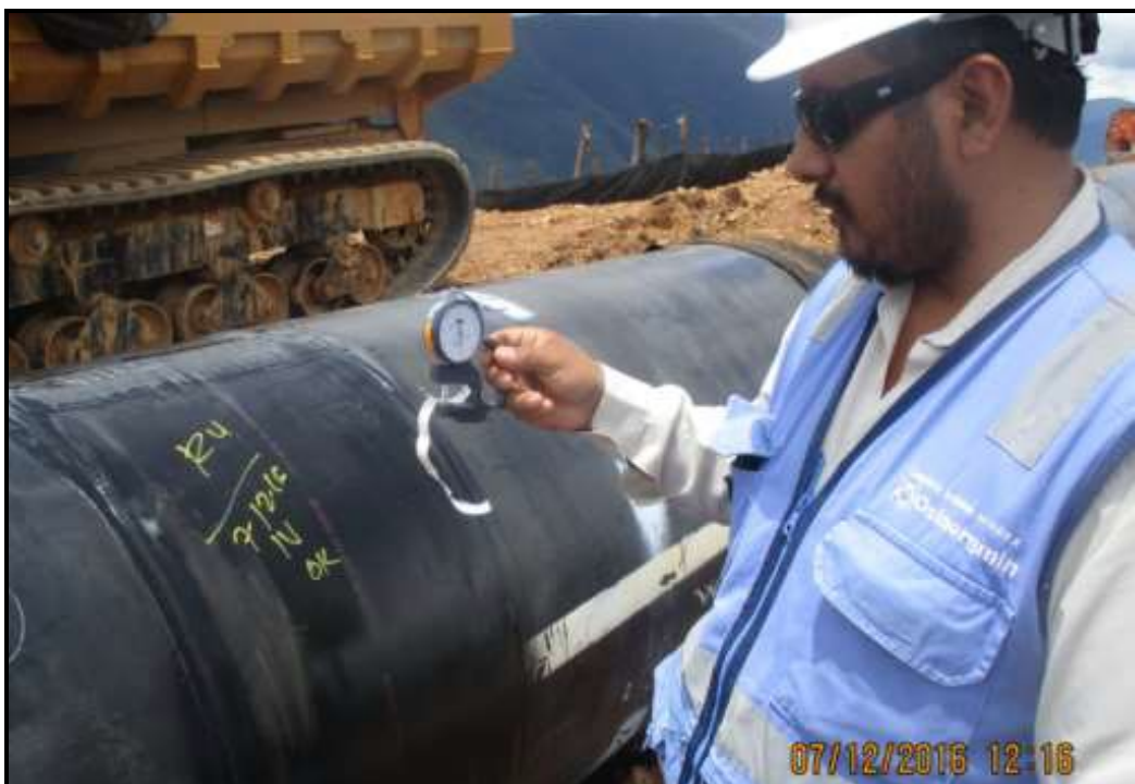
Tramo A1 - Segmento 04, KP-0152+516 Medición de la rugosidad donde se evidencia que el valor obtenido está dentro del rango.
