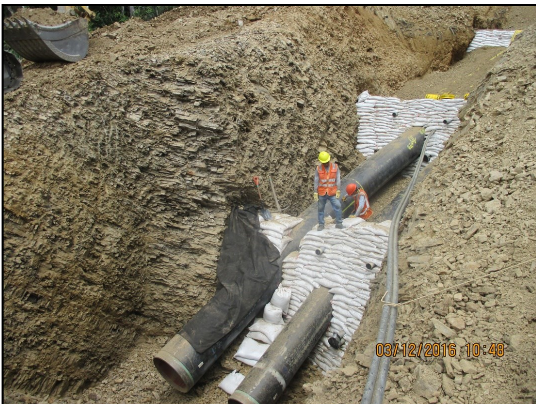
Tramo B-Segmento 02 Verificación de tubería dentro de la zanja.
