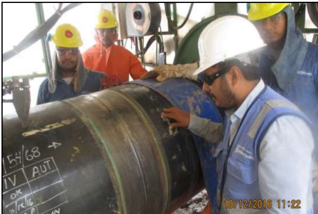
Tramo A1-Segmento 04, KP-0154+816 Supervisión del acabado de la junta soldada en el proceso de recalificación de los operadores de soldadura
