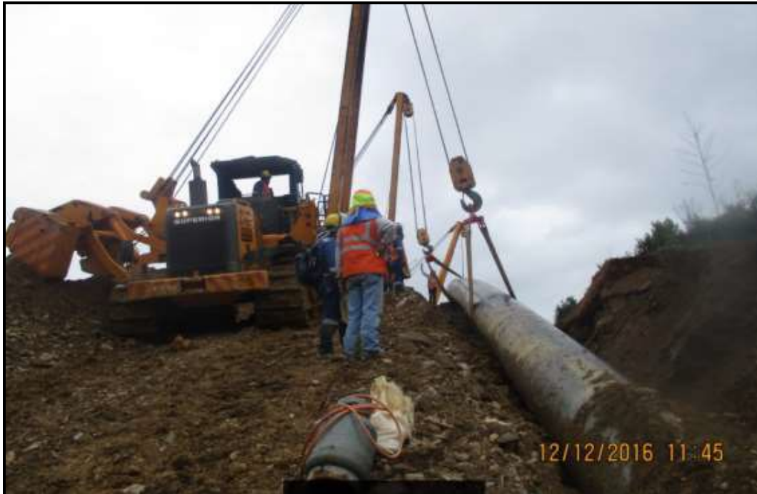
Tramo A1-Segmento 04, KP-0148+084 Supervisión de la actividad de bajado de tubería.
