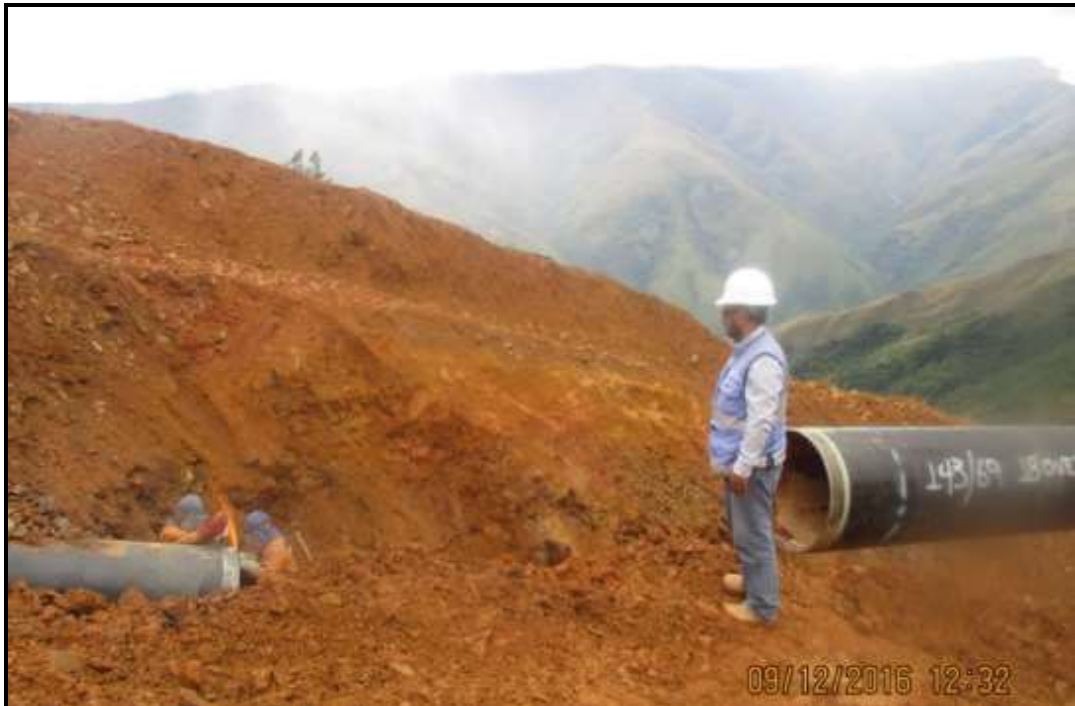
Tramo A1-Segmento 04, KP-0143+828 Se evidencia el proceso de preparación de junta J143/69.
