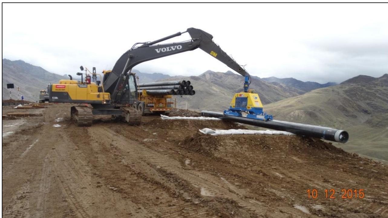
Kp 9+600. Máquina neumática que iza y baja la tubería en los puntos de desfile.
