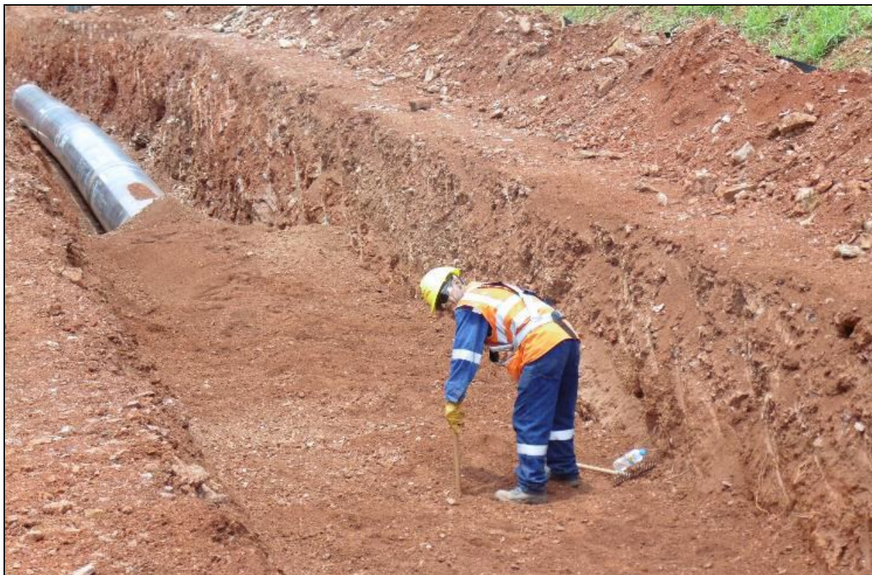
KP 132. Verificación del espesor de la “cama” de pre-tapado de la tubería, la cual debe ser de 30 cm como mínimo.
