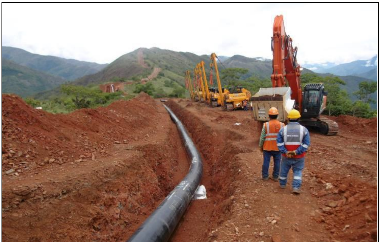
KP 132. Tramo de tubería de 32"Ø bajado a zanja, previo al tapado.
