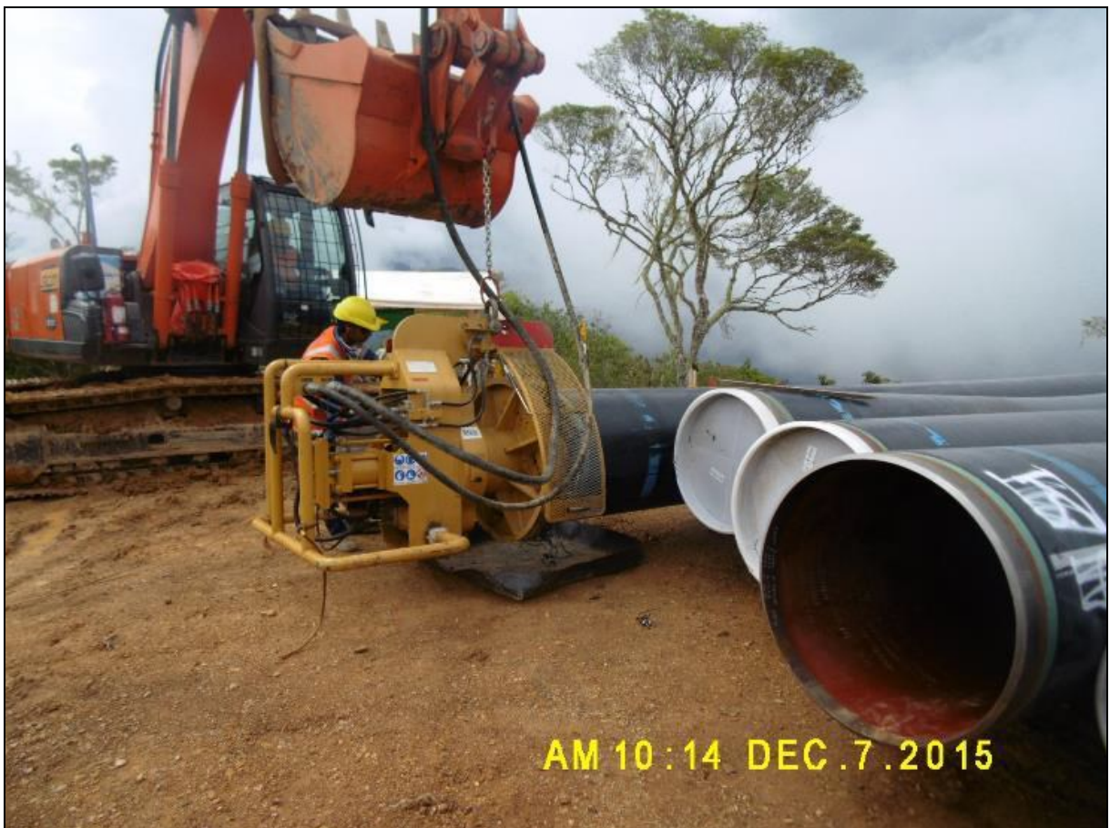
KP. 140. Actividad de biselado de tubos de 32"Ø mediante máquina neumática.
