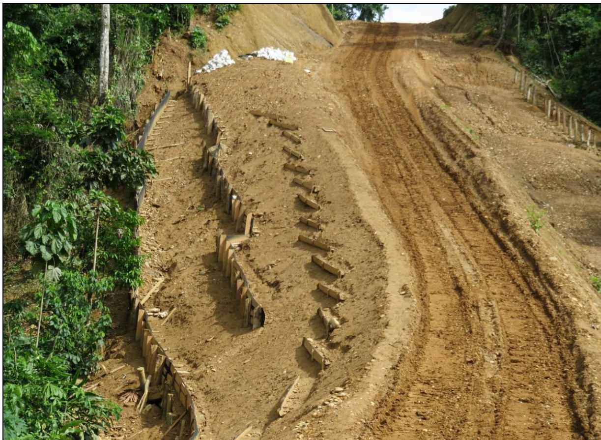
KP 8+600. Verificación de trabajos de control de erosión mediante trinchos en pendiente de fuerte inclinación.
