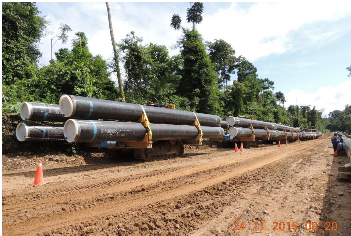
KP 10. Transporte de tubería en tractores con orugas.
