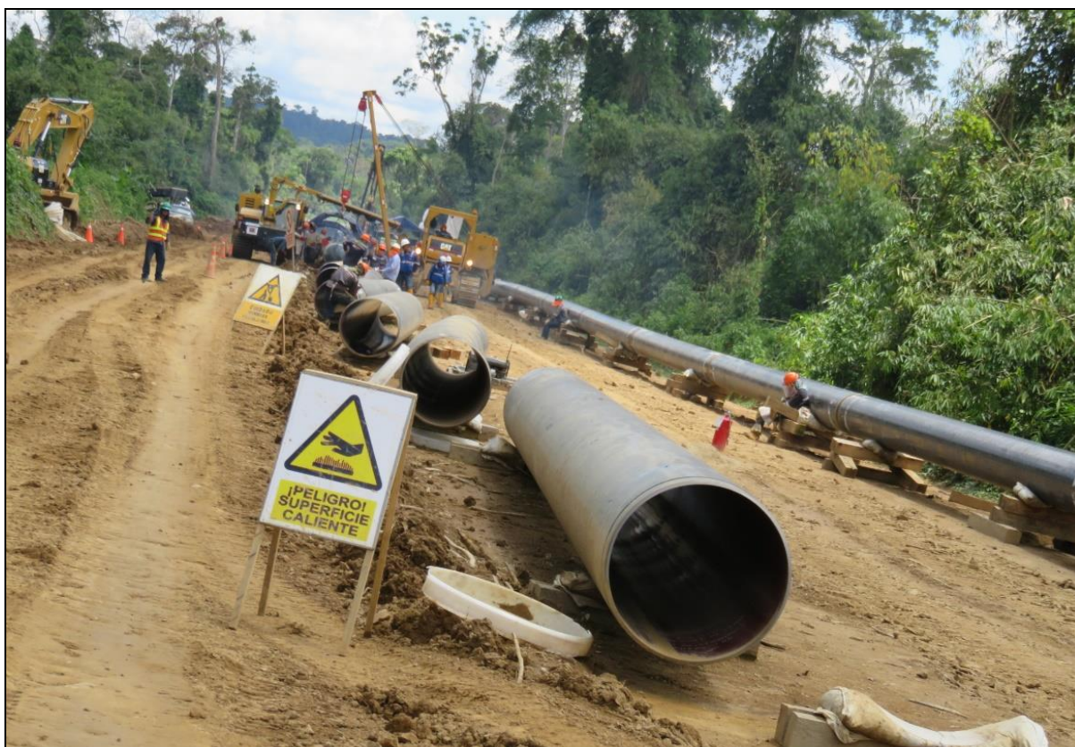
KP 14+000. Frente de avanzada de soldadura.
