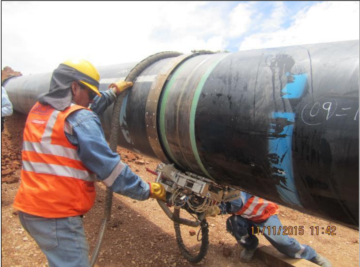
KP 132: Inspección de la soldadura mediante equipo de ultrasonido UT.
