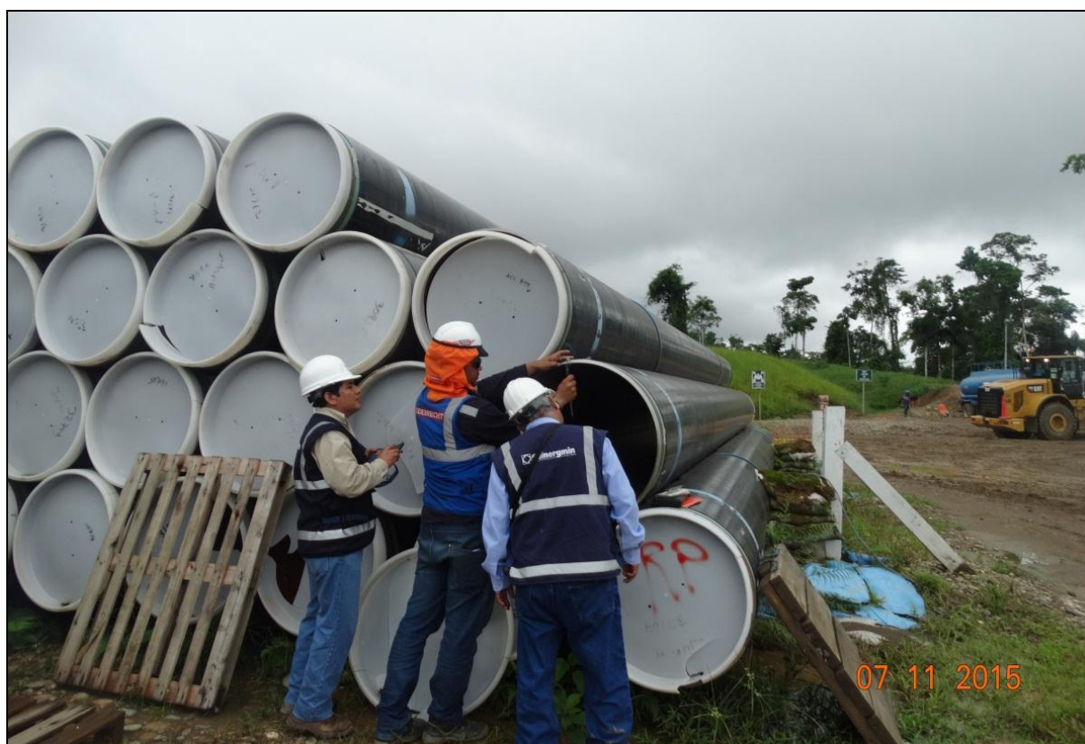
Acopio base de Ticumpinía, midiendo espesor de tubería de 24"Ø
