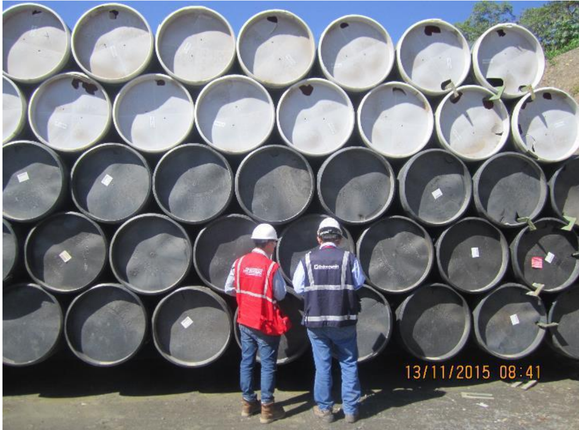
Inspección de tubos en el acopio de Quellouno.
