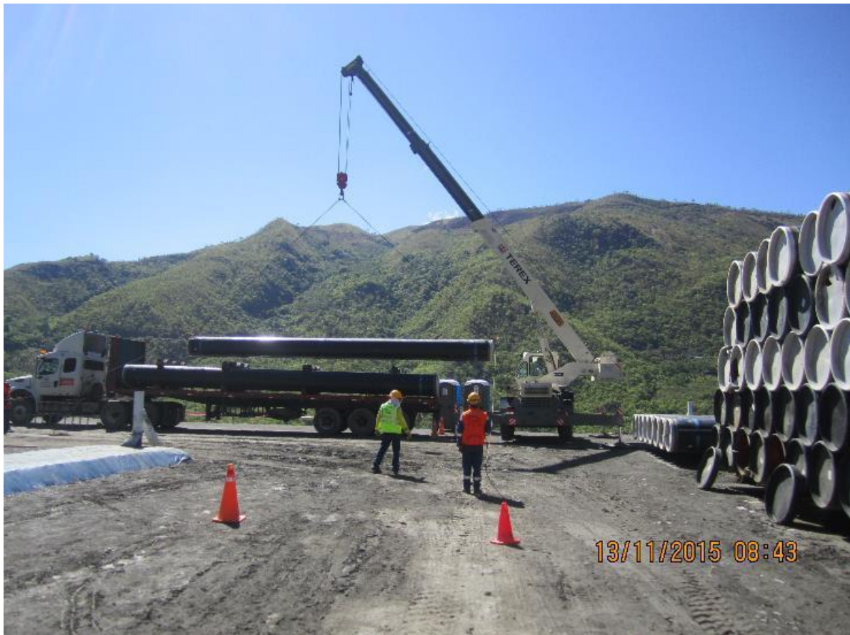
Acopio de Quellouno maniobras de izaje de uno de los tubos
