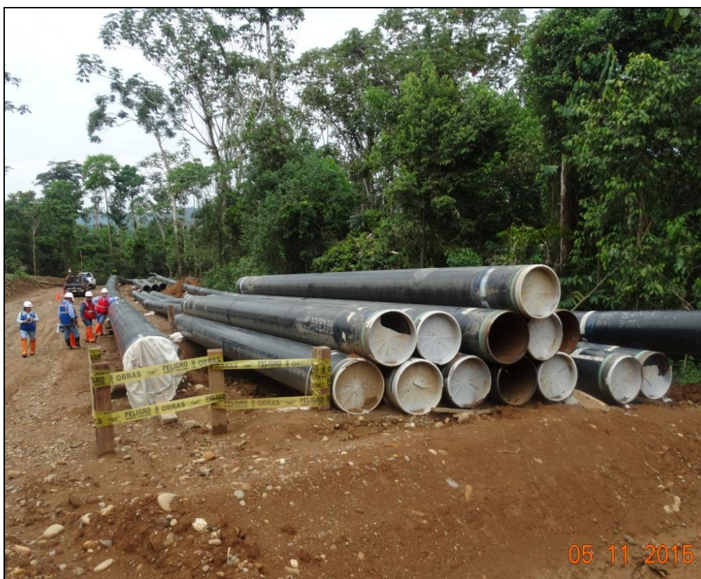
Acopio temporal ubicado en el Kp 7+060
