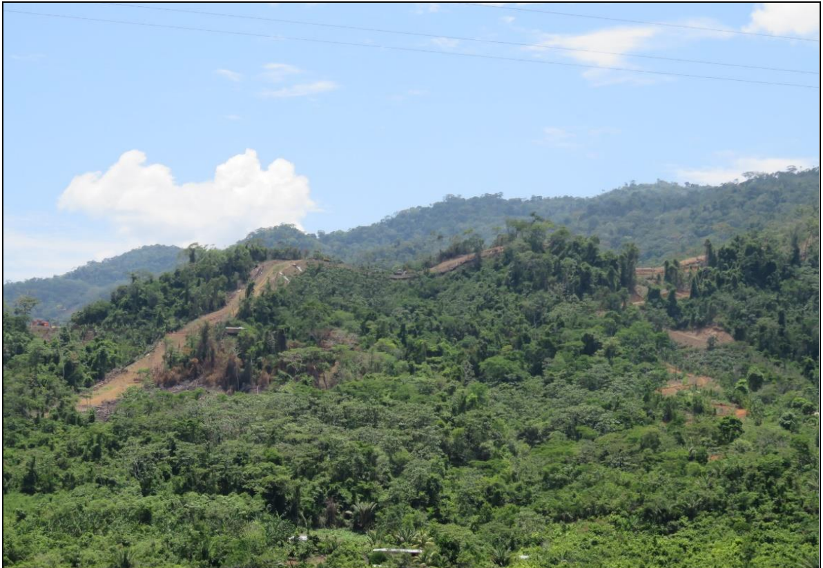
KP 87+400.- Panorámica del DDV atravesando por una topografía accidentada con una pendiente promedio de 22° en suelos limo arcillosos.
