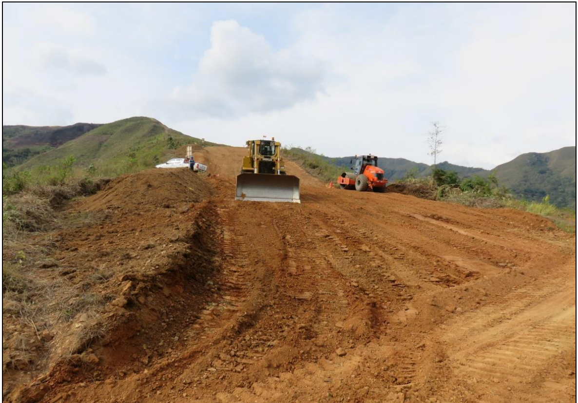
Apertura de pista del DDV en el Ramal Quillabamba.
