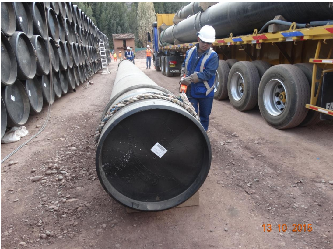
Verificación del revestimiento de la tubería
