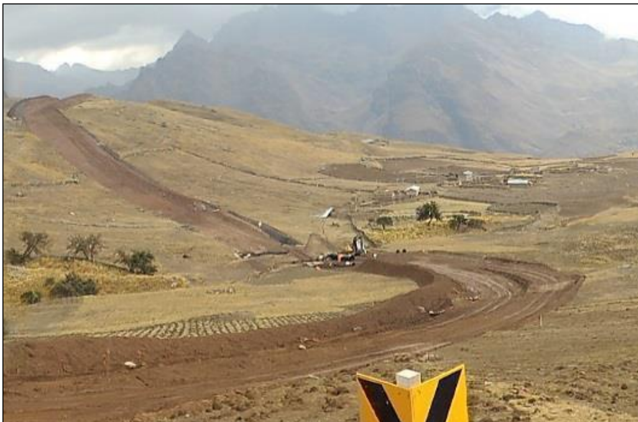
Tramo Anta-Cusco. Del KP 6+900 al KP 10+300 se verificó que los anchos del DDV son menores a 20 metros.
