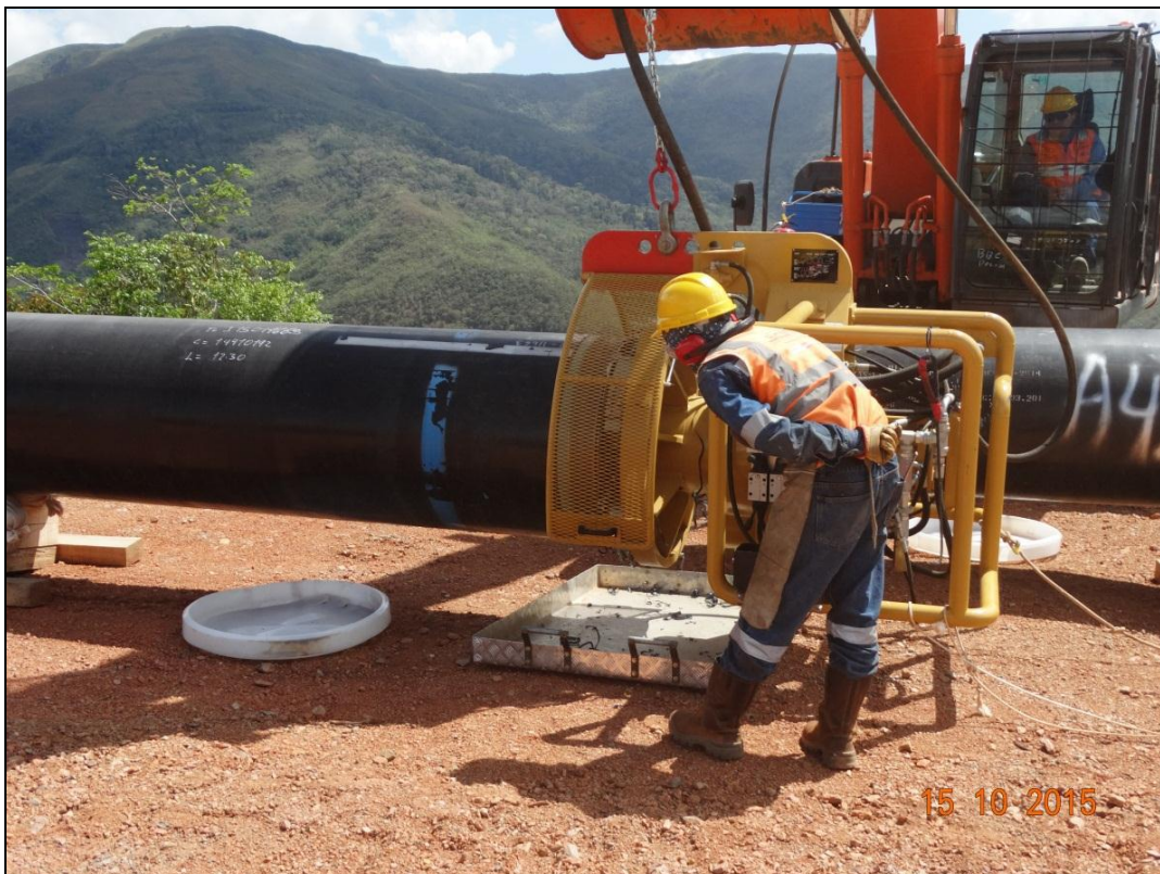
Máquina de biselado de la tubería
