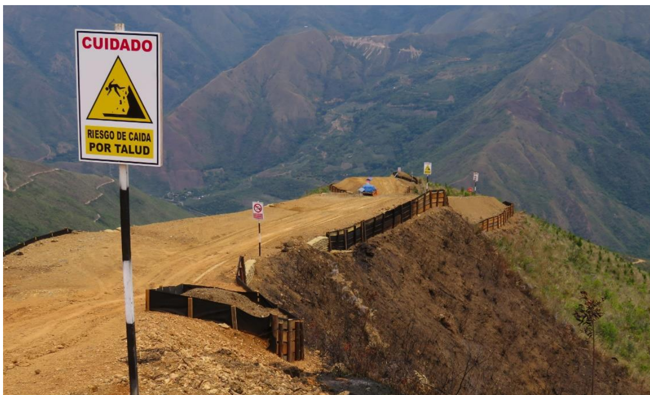
KP 3+300 del Ramal a Quillabamba. Lomo angosto limitado por trinchos de contención en ambas márgenes y señalización del área.
