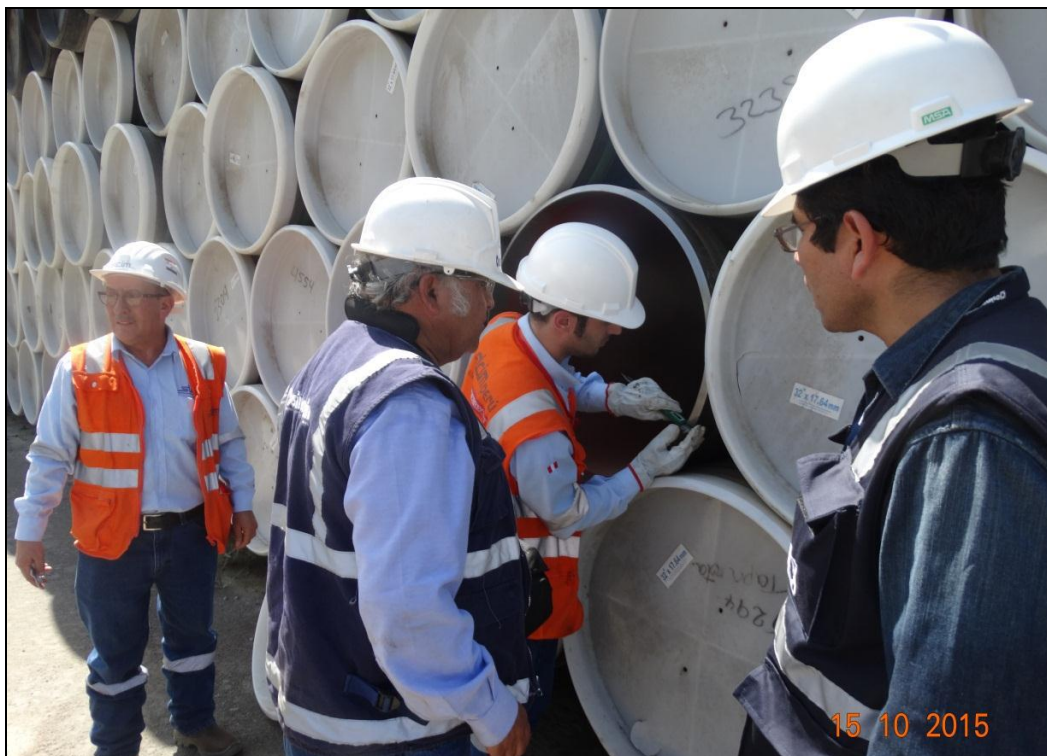
Acopio de Palma Real. Verificando espesor de tubería.
