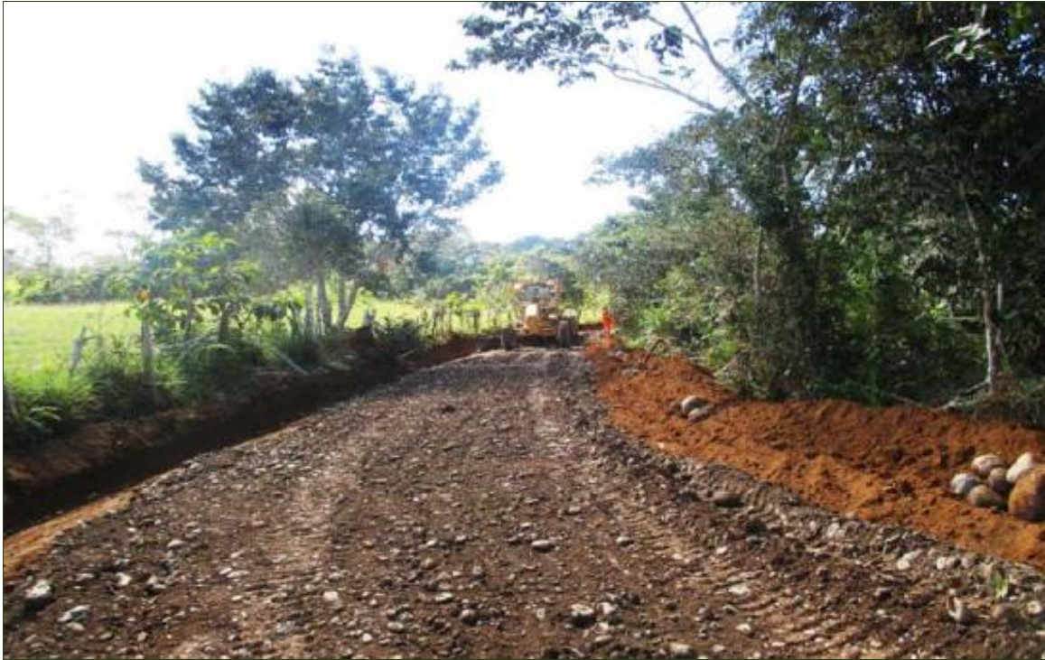
Foto 7 – Mejoramiento de plataforma de vía – colocación y compactación de afirmado en plataforma del acceso al segmento 3 del tramo A1.
