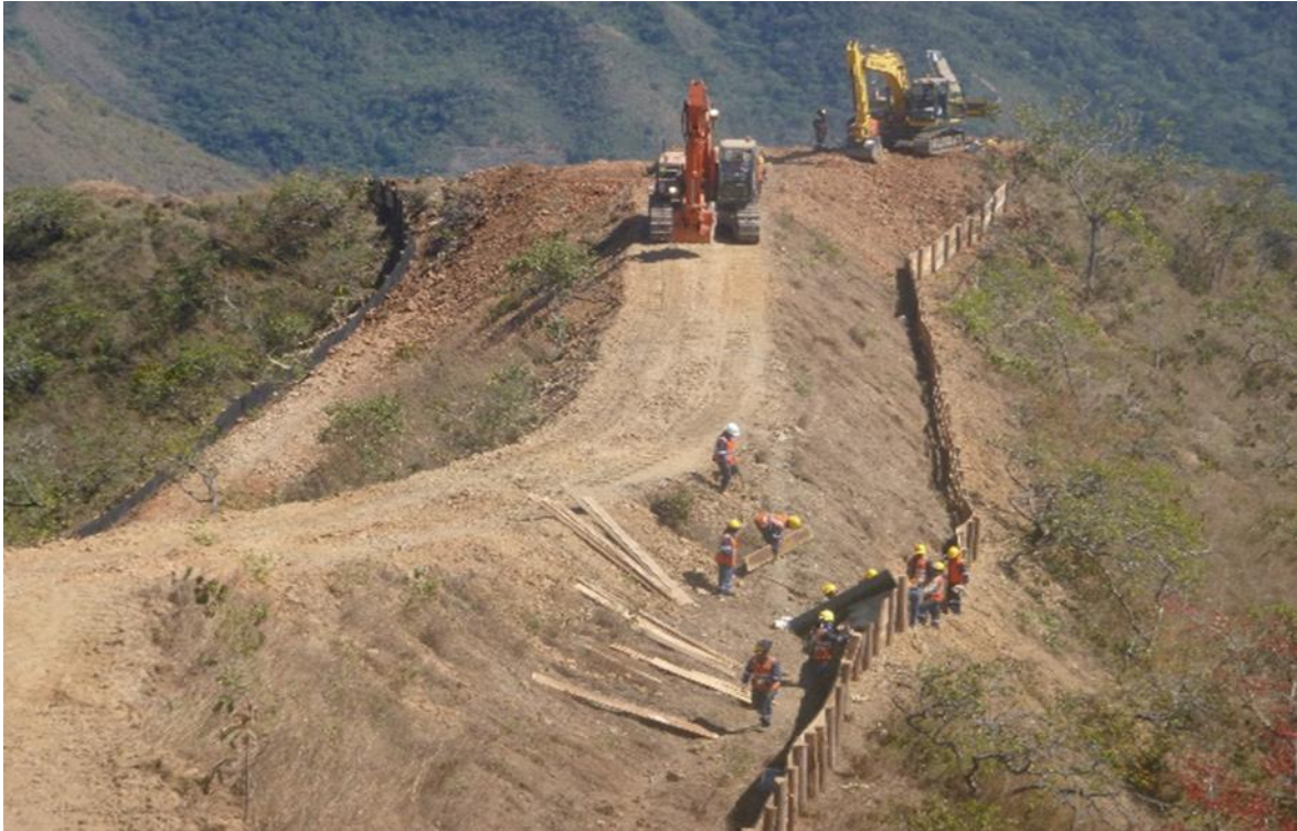
Foto 9: KP 132+400, Construcción de Trinchos
