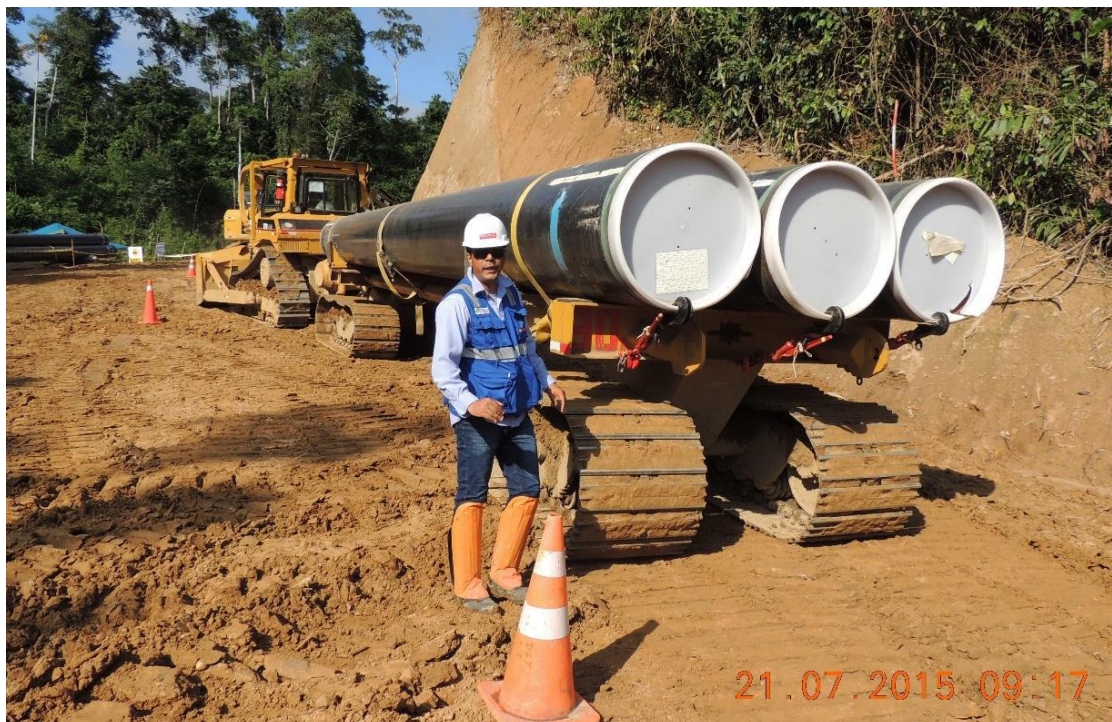
Foto 03: Máquina Caterpillar transportando tubería
