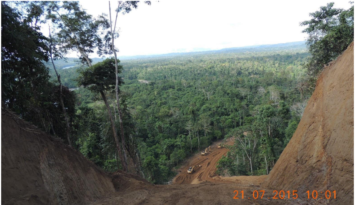
Foto 01: Relieve accidentado en ruta del DDV, entre los KPs 10 y 12 del ducto.
