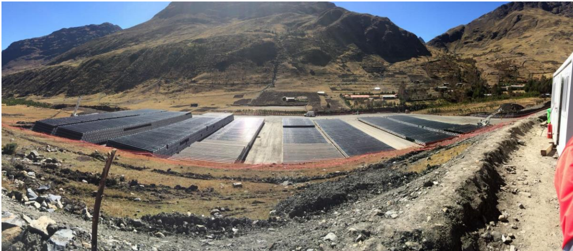
Foto 5. Acopio KP 276 de la Troncal GSP (UTM: 19L 183787E, 8548282N).- Vista panorámica del área de acopio de tuberías de 32". El acopio se ubica a 3840 msnm en la margen izquierda de quebrada afluente al río Yanatile.
