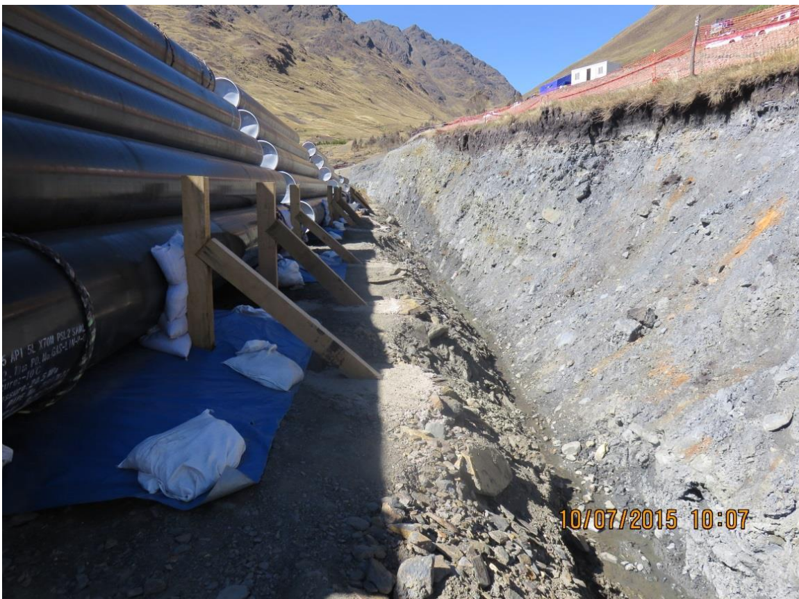
Foto 6 – Vista de uno de los lados del Acopio del KP 276 (UTM: 19L 183787E, 8548282N), obsérvese la canaleta realizada en el pie del corte de talud para evacuar las aguas de escorrentía superficial y el de filtración en el talud. Zona estable.
