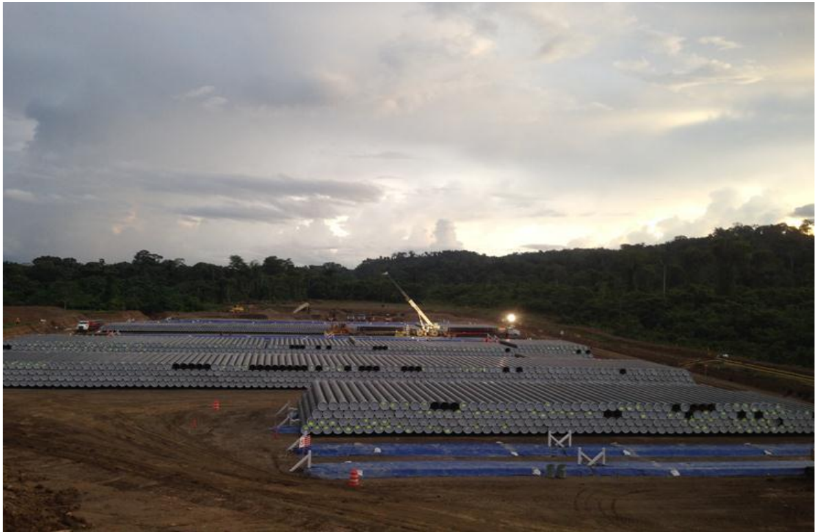
Base Ticumpinia, acopio de tuberías
