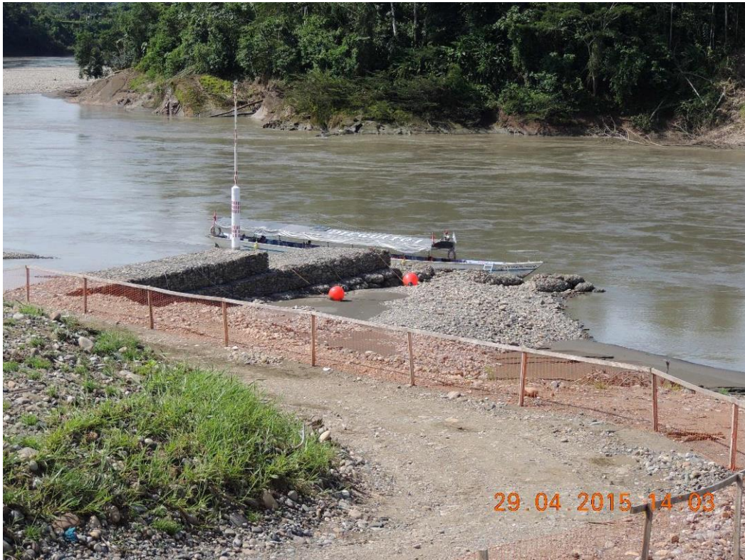
Foto 01: Vista del embarcadero de Ticumpinia: Barreras de contención en mejora constante.
