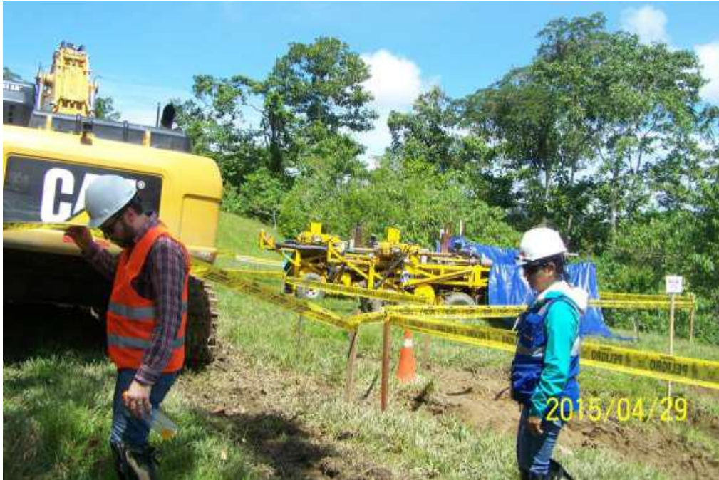
Foto-01: Perforación Horizontal Dirigida del Urubamb, KP-004+500 (Aprox.). Trabajos preliminares de movilización de equipos, para hacer las perforaciones verticales, que proporcionen el detalle de la estructura del subsuelo, por donde se piensa hacer la perforación, para cruzar en forma subterránea el Rio Urubamba.
