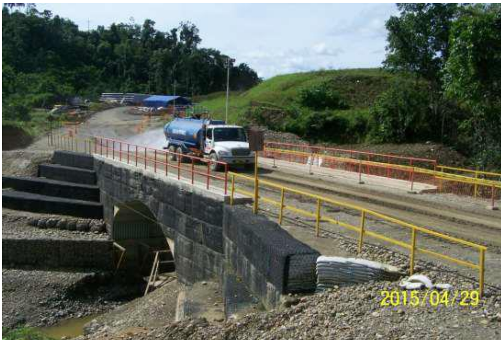
Foto-02: Visita al Campamento Ticumpinía, desde el punto de vista geotécnico en el área donde se ubica el puente no hay presencia de anomalías ni áreas desestabilizadas.
