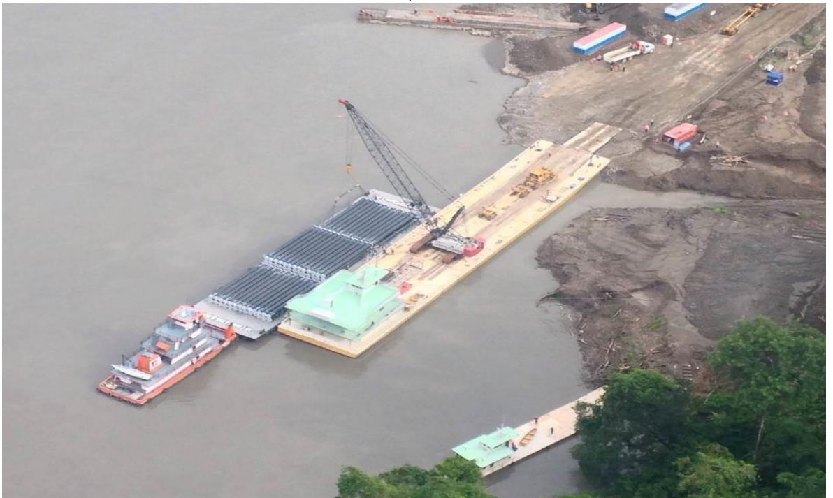
Base Ticumpinia, descarga de tuberías, a orillas del río Urubamba
