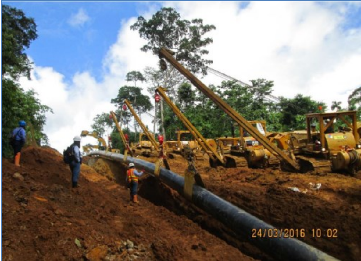
Tramo B-Segmento 1, KP-15+982, Bajada de tubería con 4 side booms.
