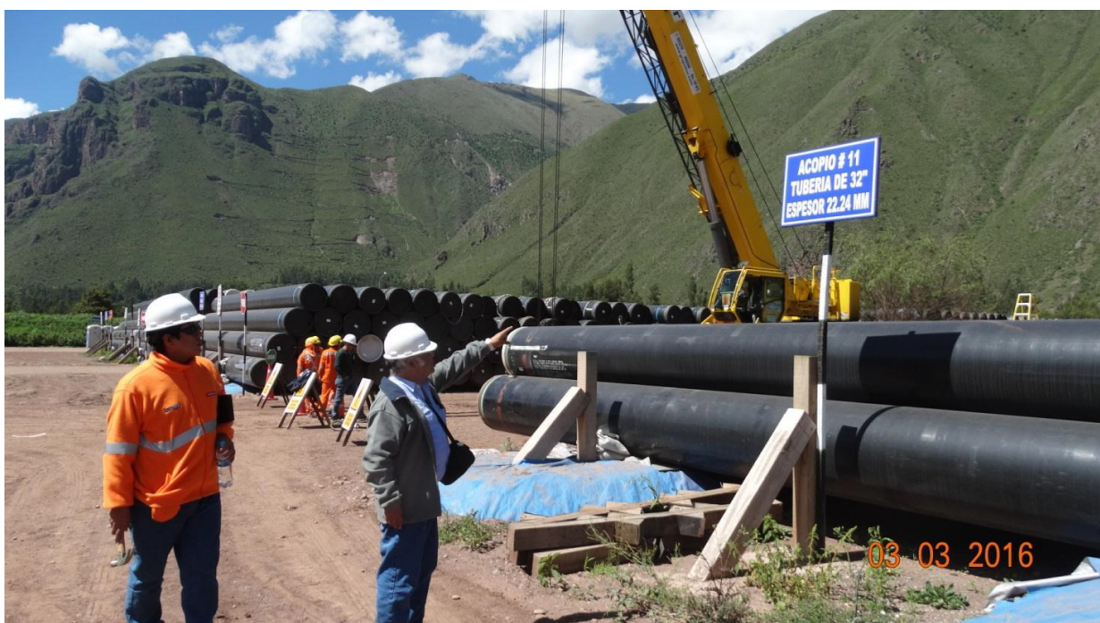
Acopio Calca. Supervisión de la tubería de 32"Ø
