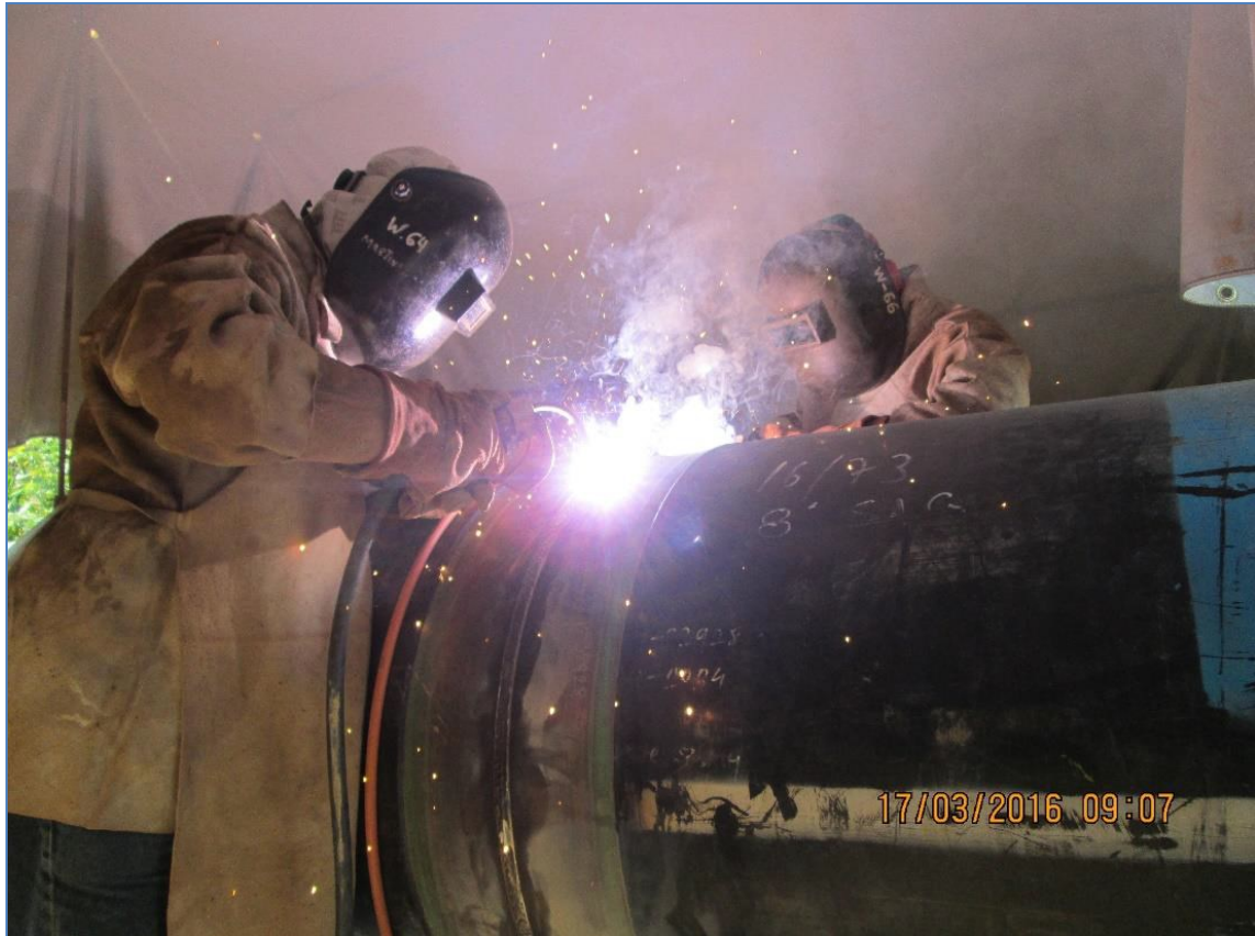
Tramo B-Segmento 1, KP 16+881. Proceso de Soldadura de la junta 16/73.
