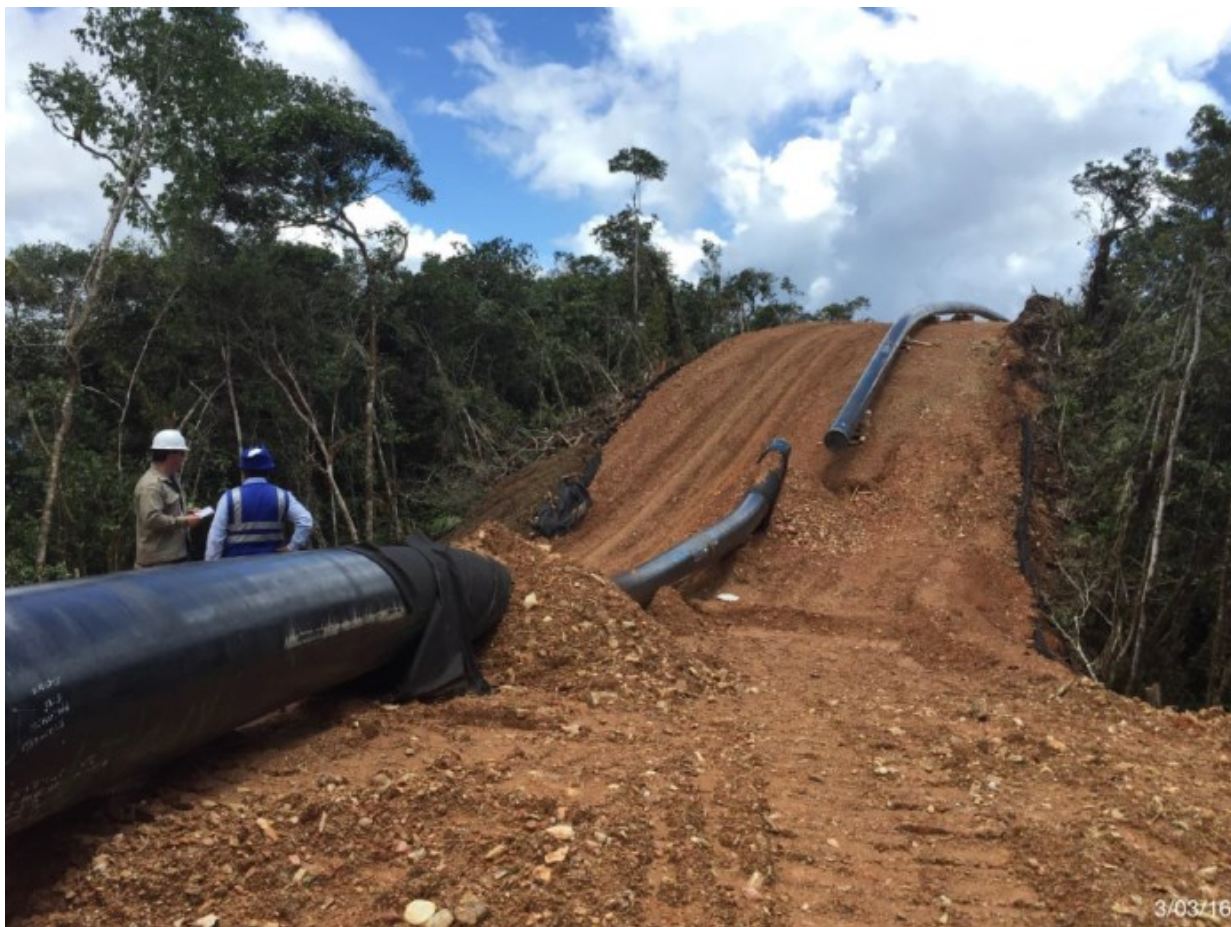
Segmento 03 del Tramo A1, KP 93+113, vista de la tubería de 32"Ø.
