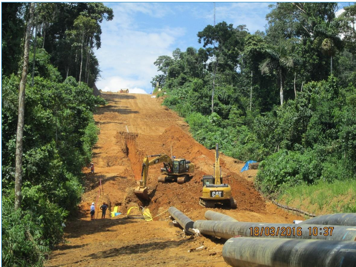
Tramo B-Segmento 1, KP 8+110. Vista panorámica del frente de apertura de zanja
