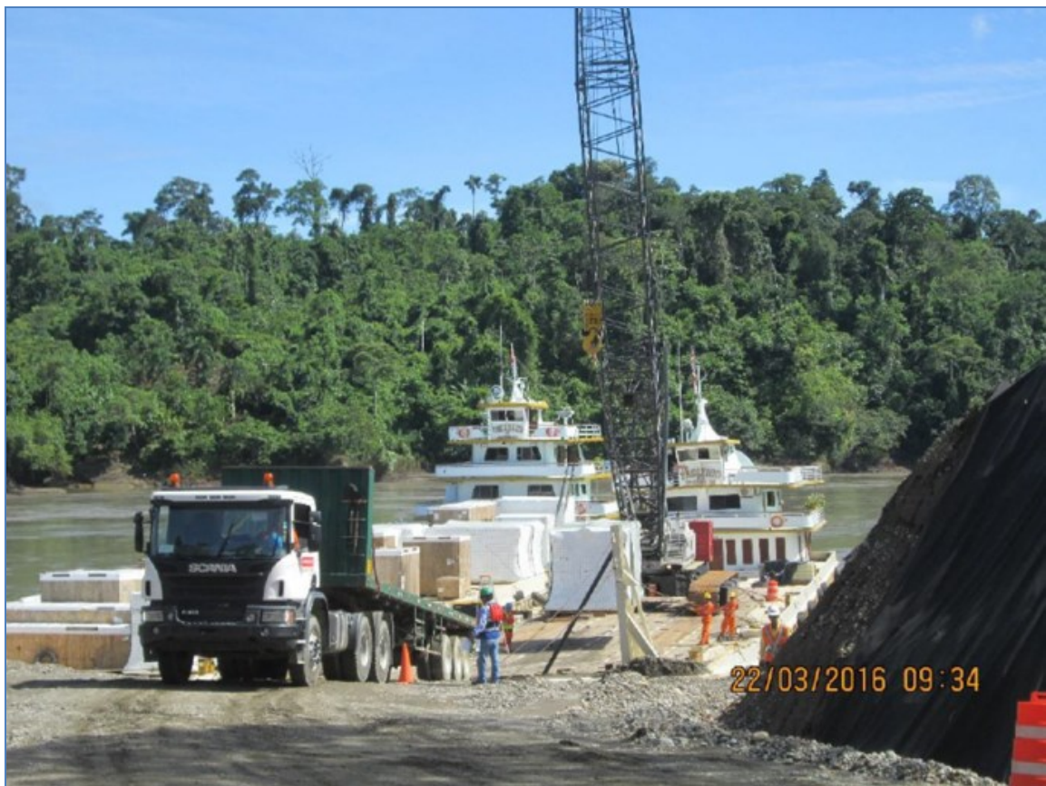
Tramo B-Segmento 1. Descarga de Equipos y accesorios para la Estación Compresora del KP 4.
