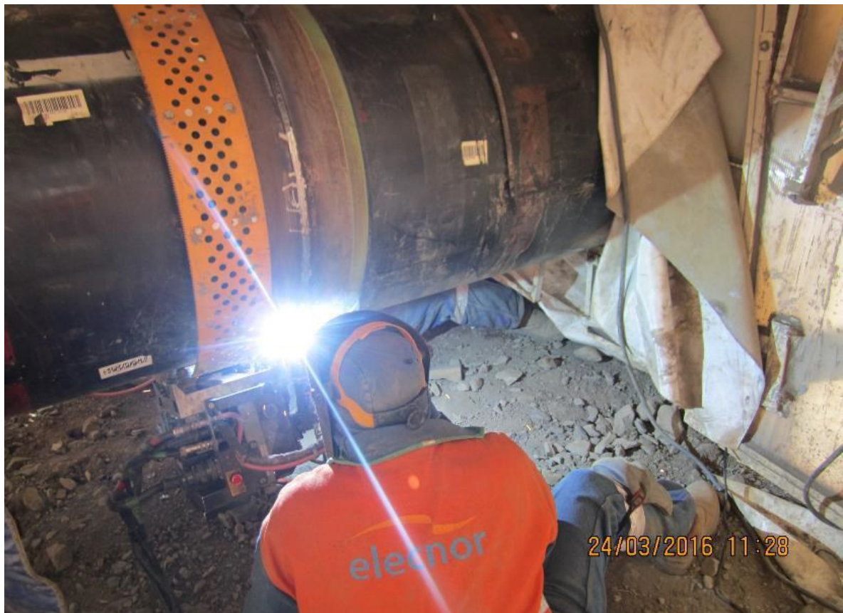
Tramo A1 - Segmento 5, KP-0278+702. Soldado de la junta N° 278/57.
