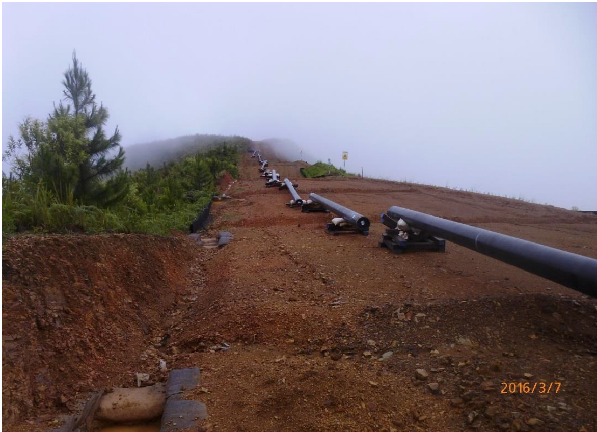
Gasoducto Secundario a Quillabamba, KP-003+000. Actividad de desfile de tubos.
