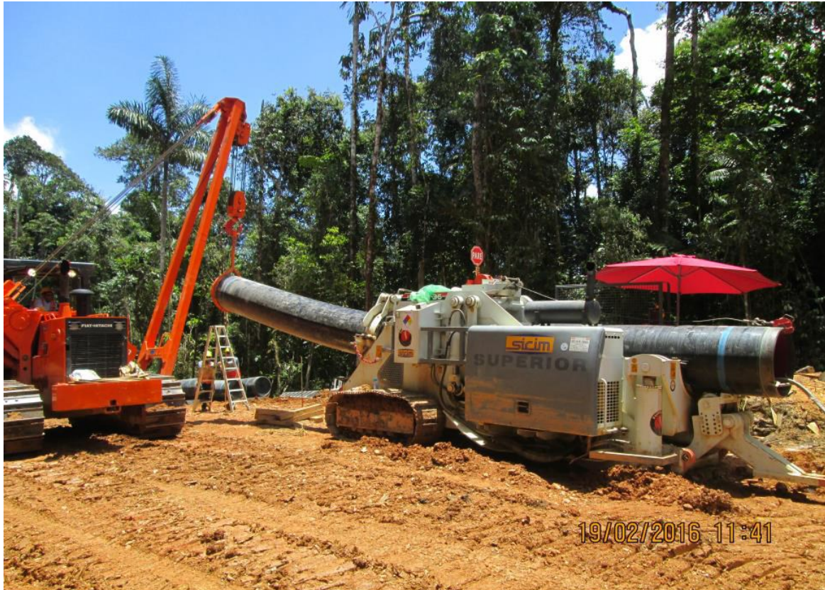
Segmento 03 del Tramo A1. Proceso de Curvado de tubería.
