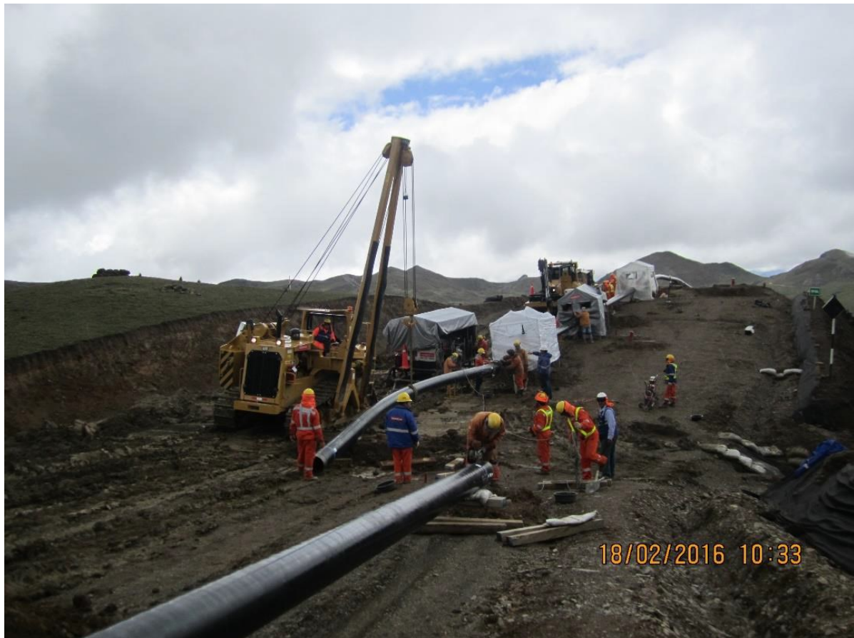
Gasoducto Secundario a Anta, KP 05+829. Actividad de soldadura.
