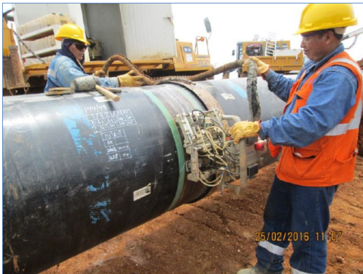
Segmento 04 del Tramo A1, KP0144+592. Proceso de verificación por ultrasonido de la junta de soldadura N° 144/49
