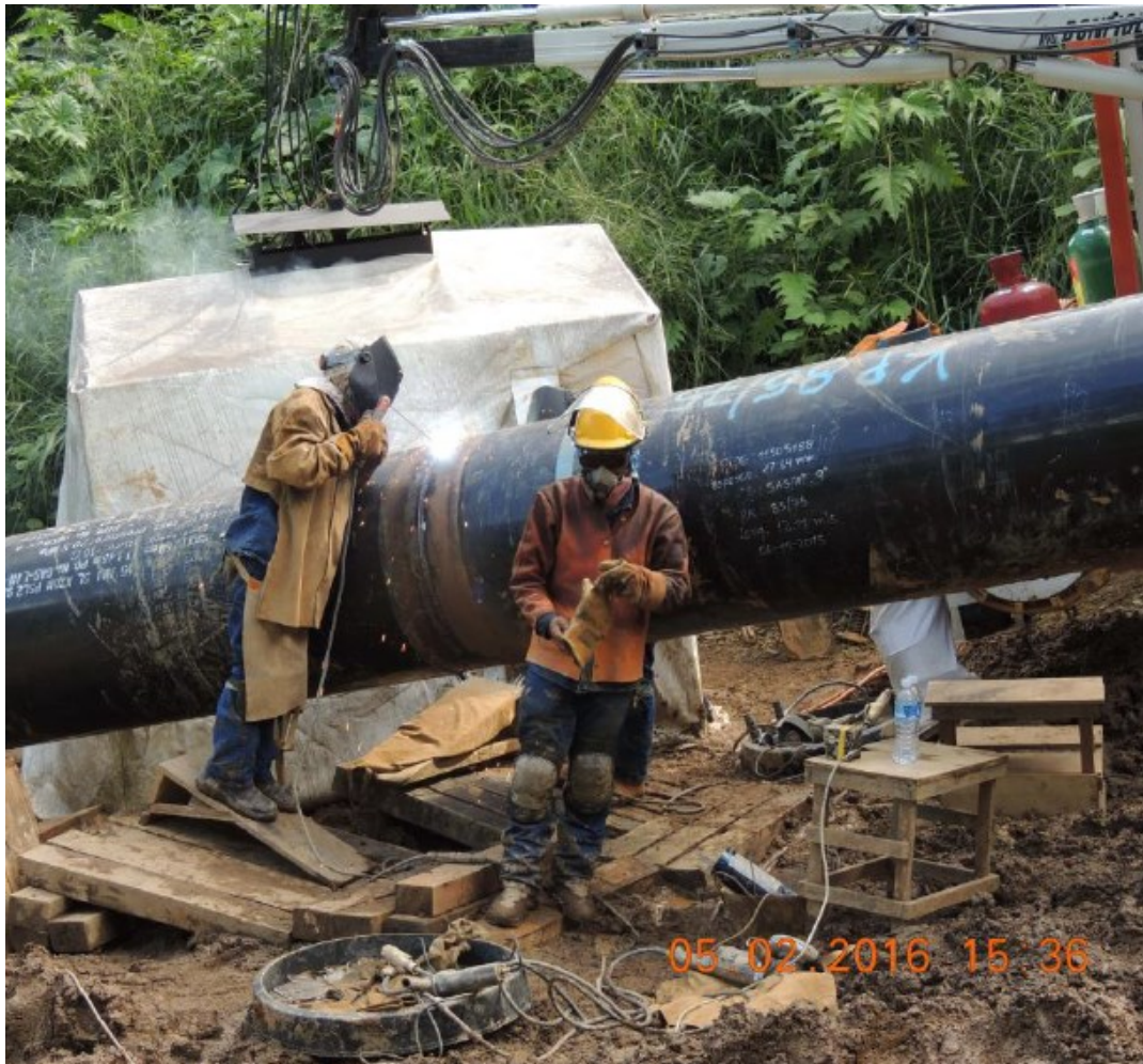
Segmento 03 del Tramo A1. Supervisión de trabajos de soldadura.
