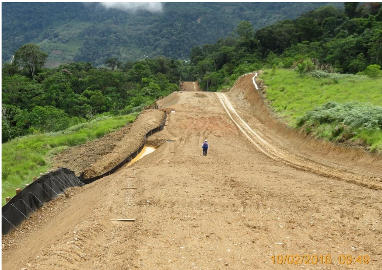
Segmento 03 del Tramo A1, KP-0095+300, DDV emplazado en media ladera.
