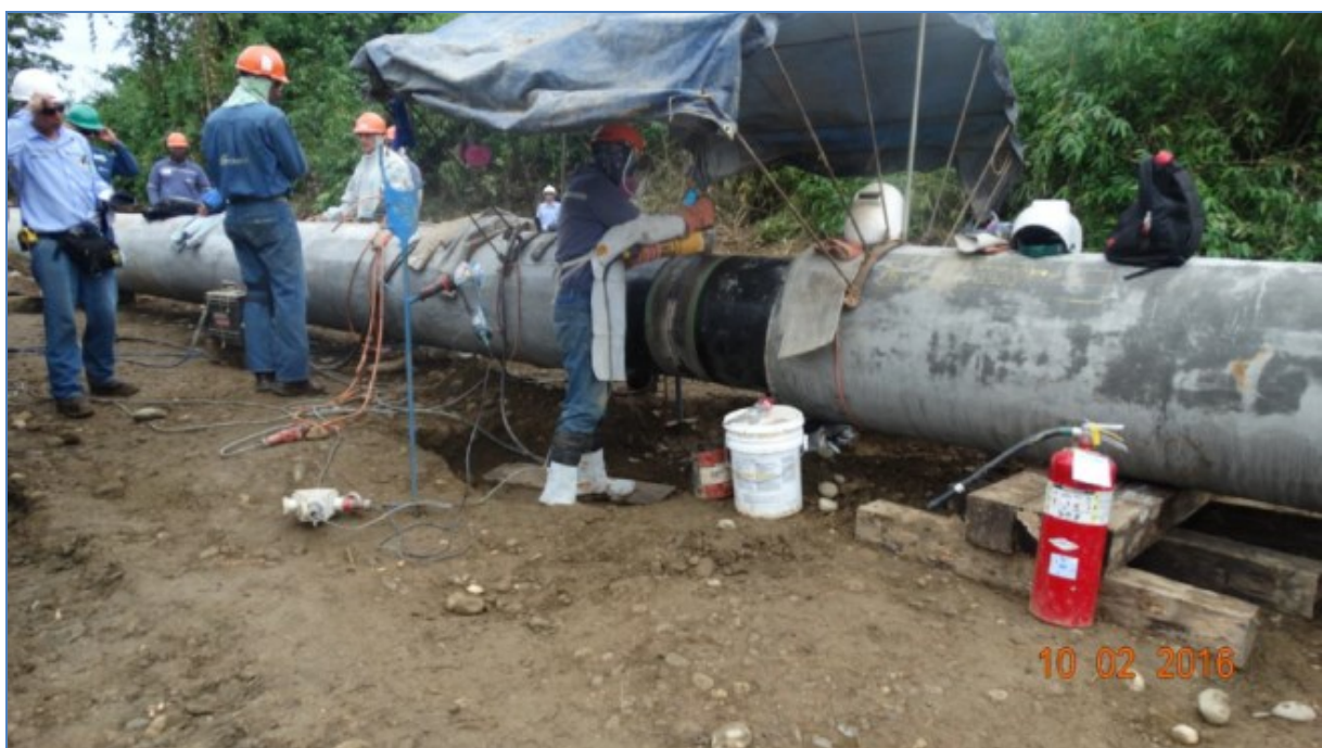
Segmento 1 del Tramo B. Preparación para el pase de relleno en junta de soldadura del ducto de 24" \varnothing .
