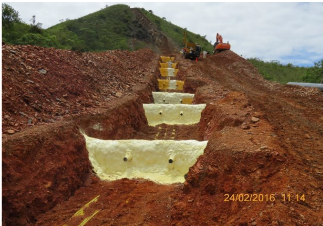
Segmento 03 del Tramo A1 (KP 134+200). Verificación de la construcción de diques de poliuretano con la finalidad de proteger el ducto.
