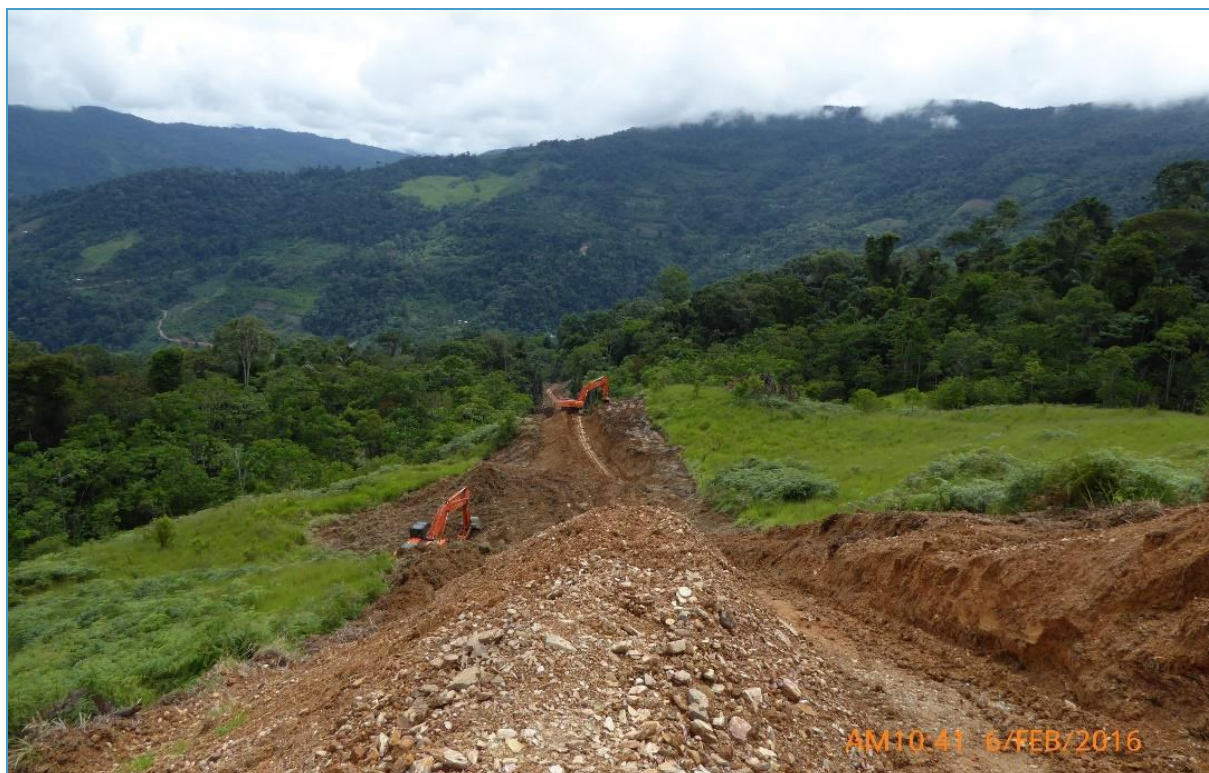
Segmento 3 del Tramo A1 - KP 95+340. Vista del DdV.
