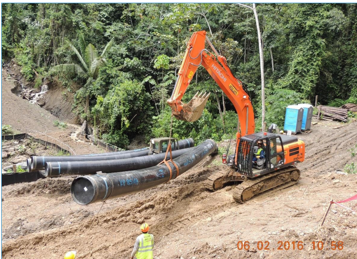
Segmento 3 del Tramo A1. Acarreo de tubos curvados.
