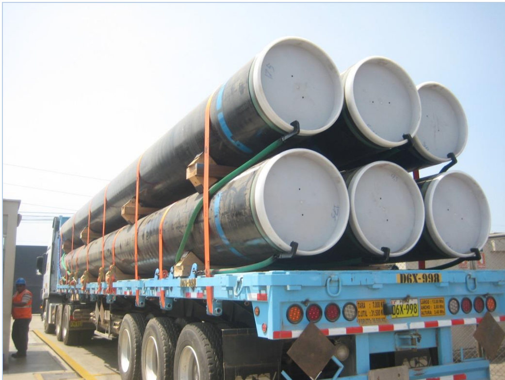
Foto-03: Camión listo para el transporte de la tubería, nótese que cada tubo está sujetado de manera independiente.
