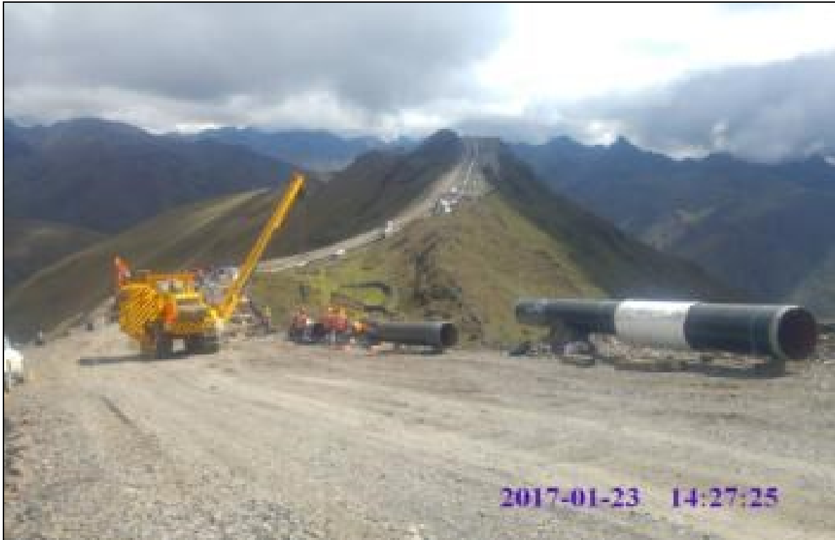
Tramo A1 – Segmento 5 (Kp 266+443). Trabajos de desfile, ducto de 32"Ø
