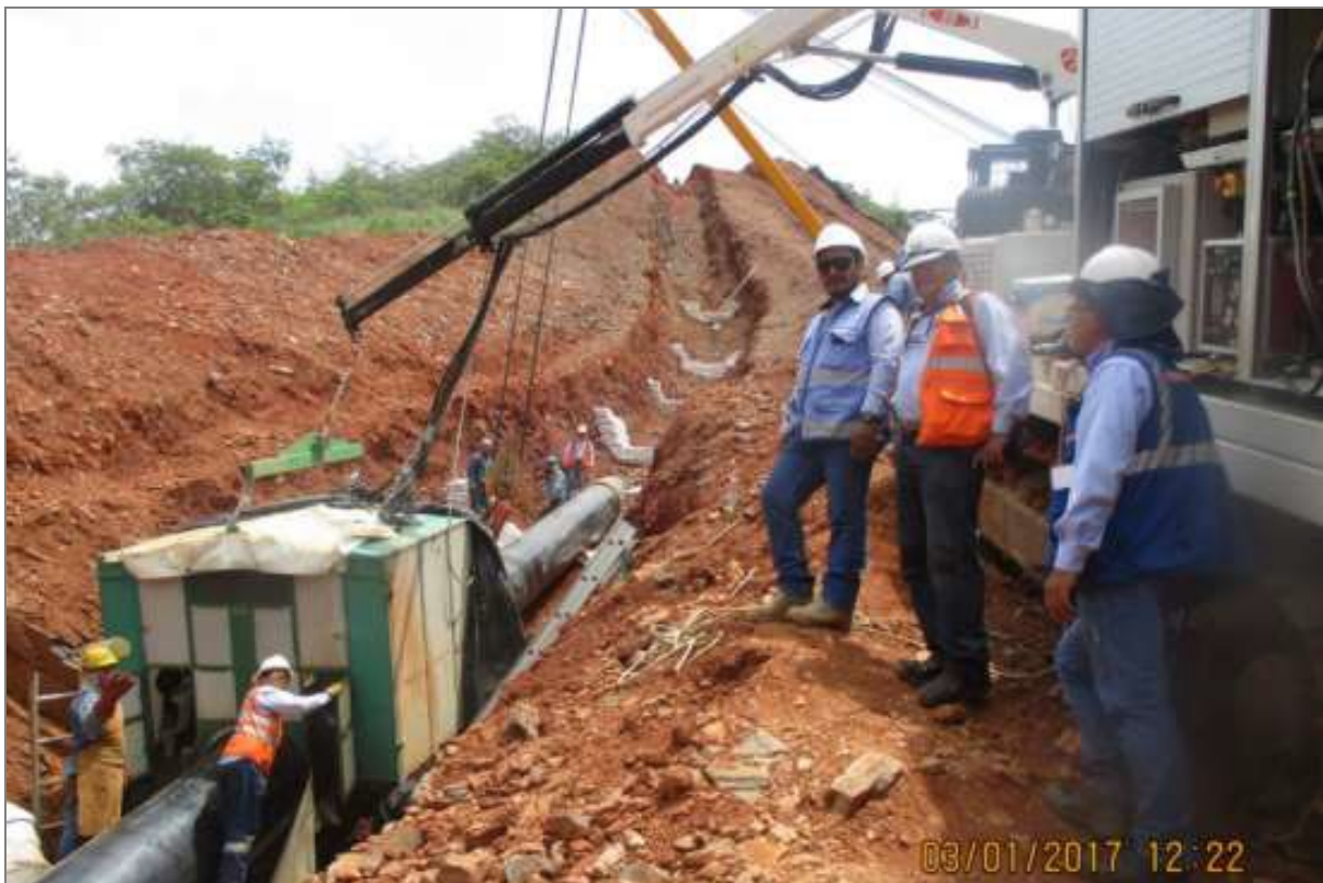
Tramo A1 - Segmento 3, KP 130+096 Actividades de control de calidad en la junta de soldadura N° J130/08
