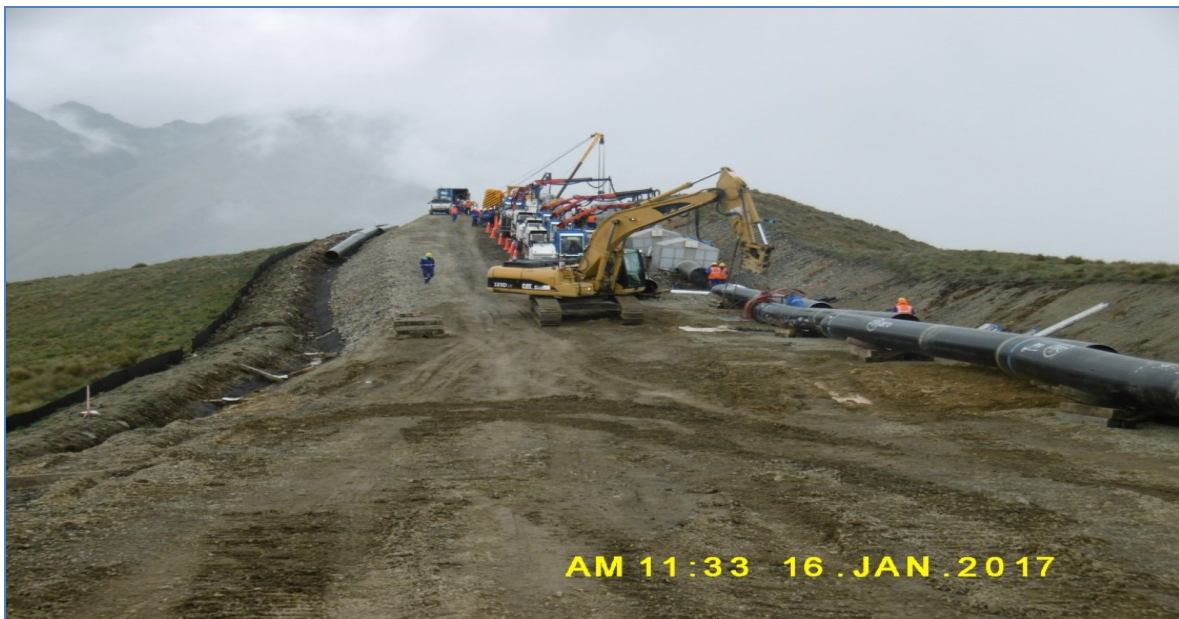
Tramo A1 – Segmento 5, KP 264+100 Actividad de desfile de ductos.
