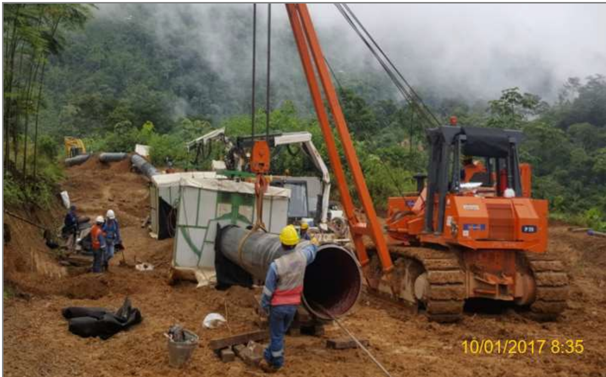
Tramo A1 - Segmento 3, KP 97+804 Disposición de la tubería para la actividad de soldadura.
