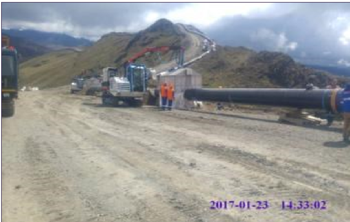
Tramo A1 – Segmento 5, KP 266+455 Actividad de soldadura, ducto de 32"Ø
