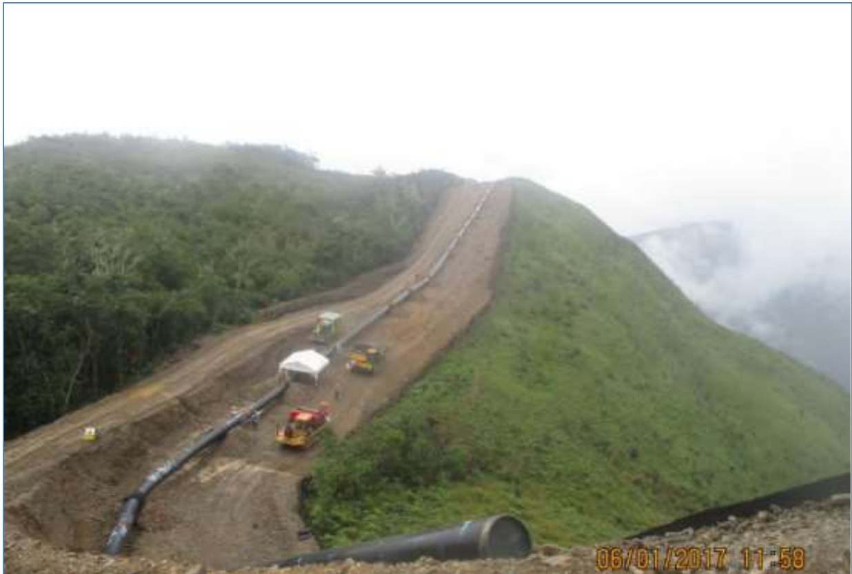
Tramo A1 – Segmento 4, KP 155+372 Vista panorámica de la tubería
