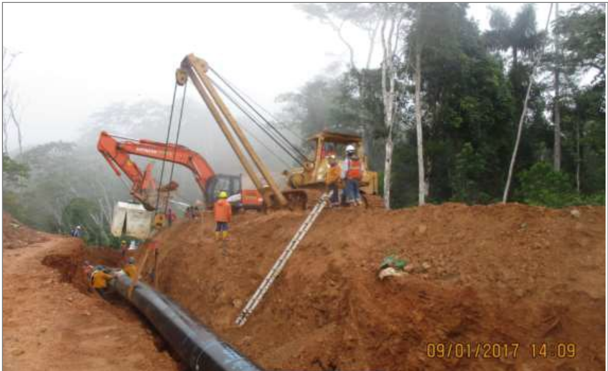
Tramo A1 – Segmento 3, KP 89+240 Actividad de bajado de la tubería
