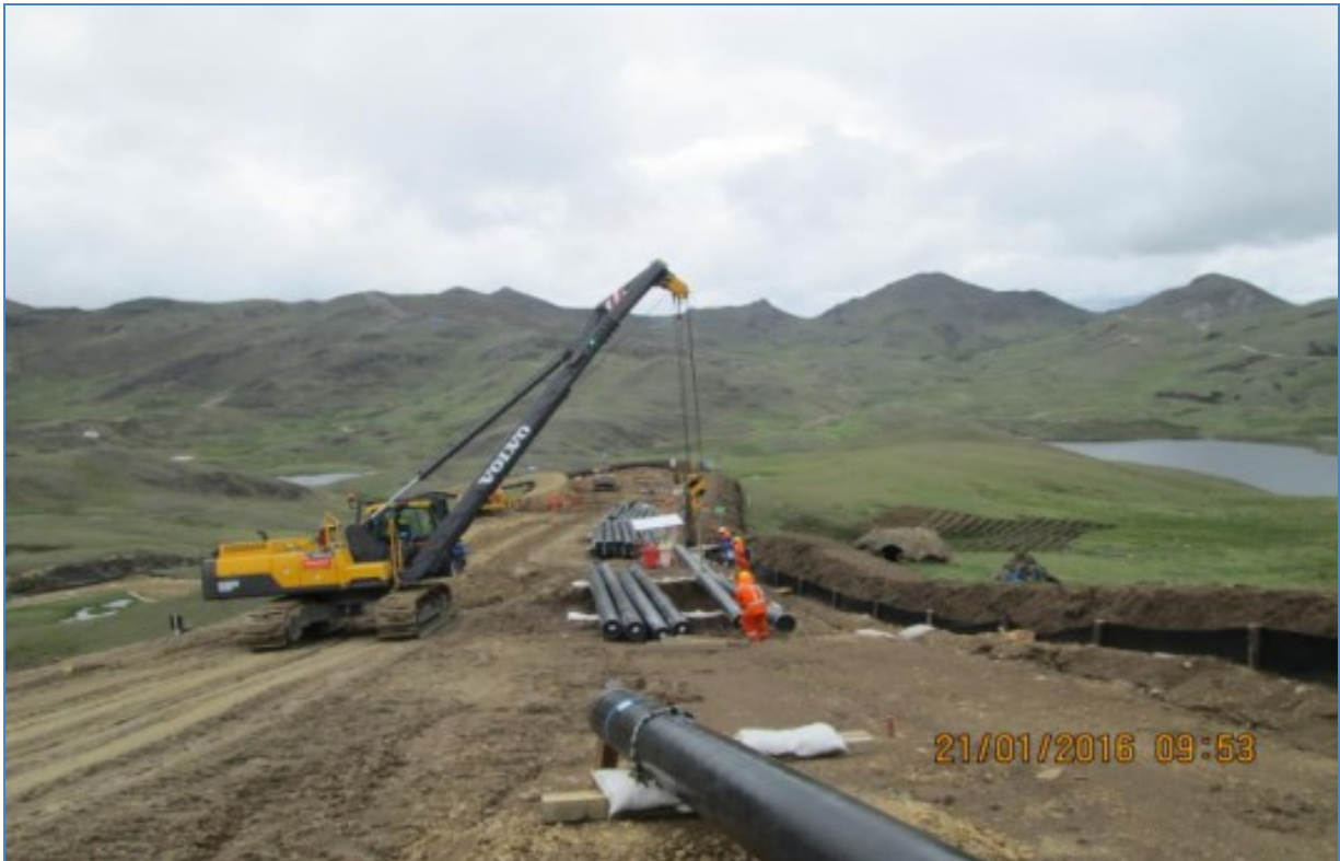
Gasoducto Secundario Cusco Anta (KP 5+415). Verificación del izaje de la tubería para ser desfilada en el DdV.
