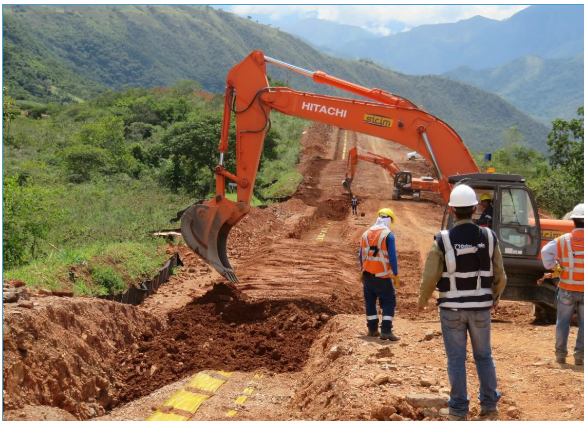
Tramo A1-Segmento 3. Verificación de la actividad de tapada de la segunda capa con material extraído de la zanja.
