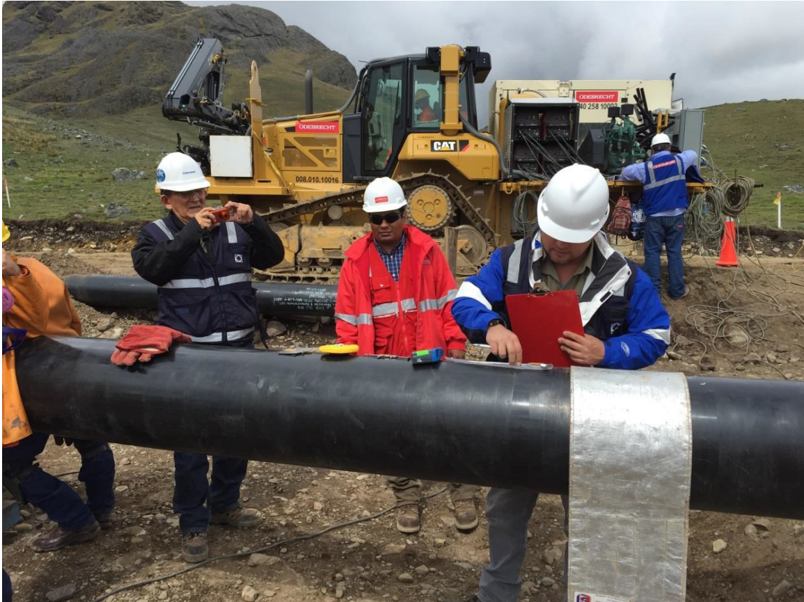
KP 000+310. Revisión de la calibración de los equipos para controlar la calidad de la soldadura.
