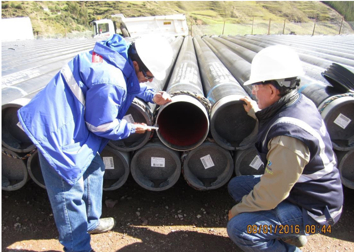
Acopio de Pampallacta: Supervisión de los ductos del Tramo A1. Verificación del espesor.
