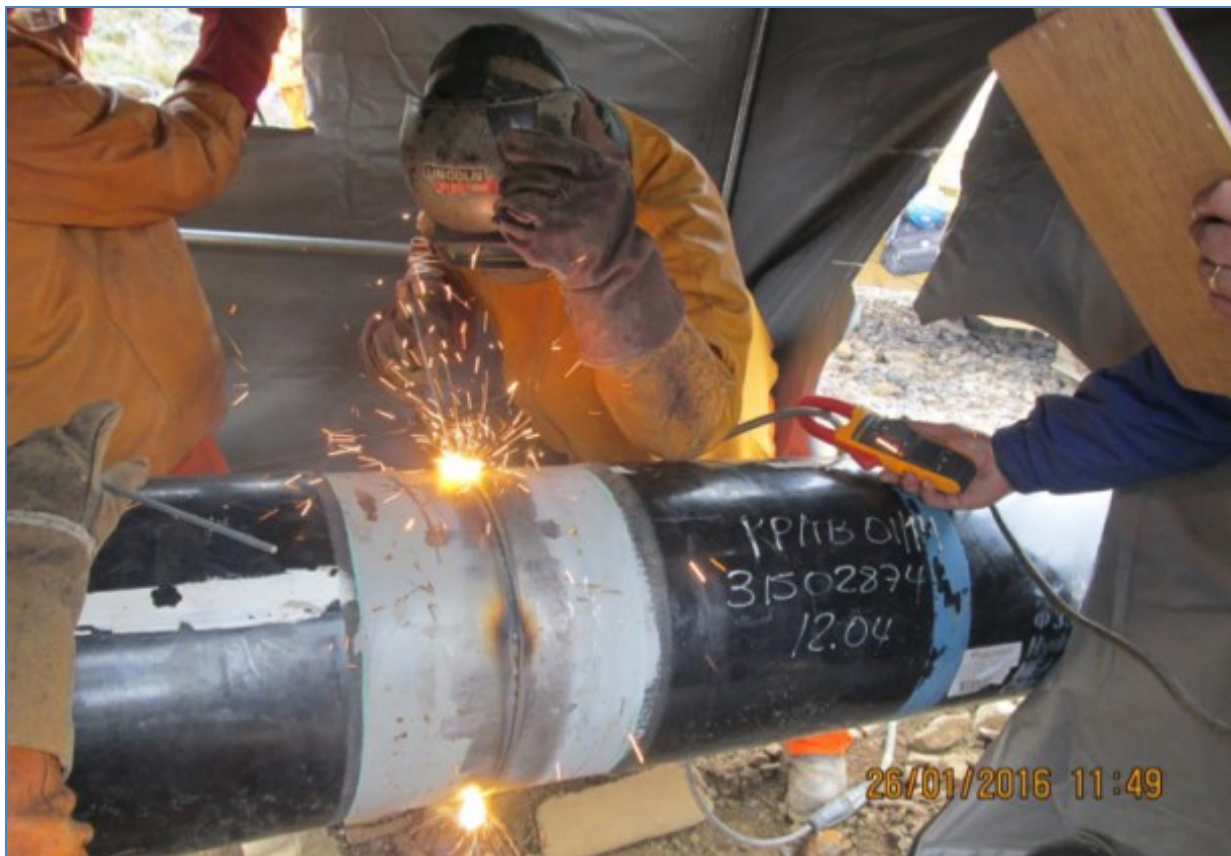
Gasoducto Secundario Cusco Anta. Verificación de Soldadura.
