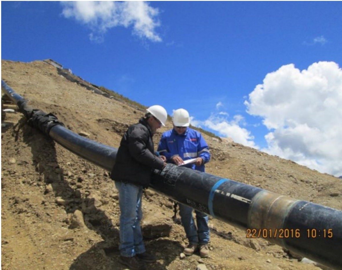
Gasoducto Secundario Cusco Anta. Verificación de la planilla de curvado de tubos.
