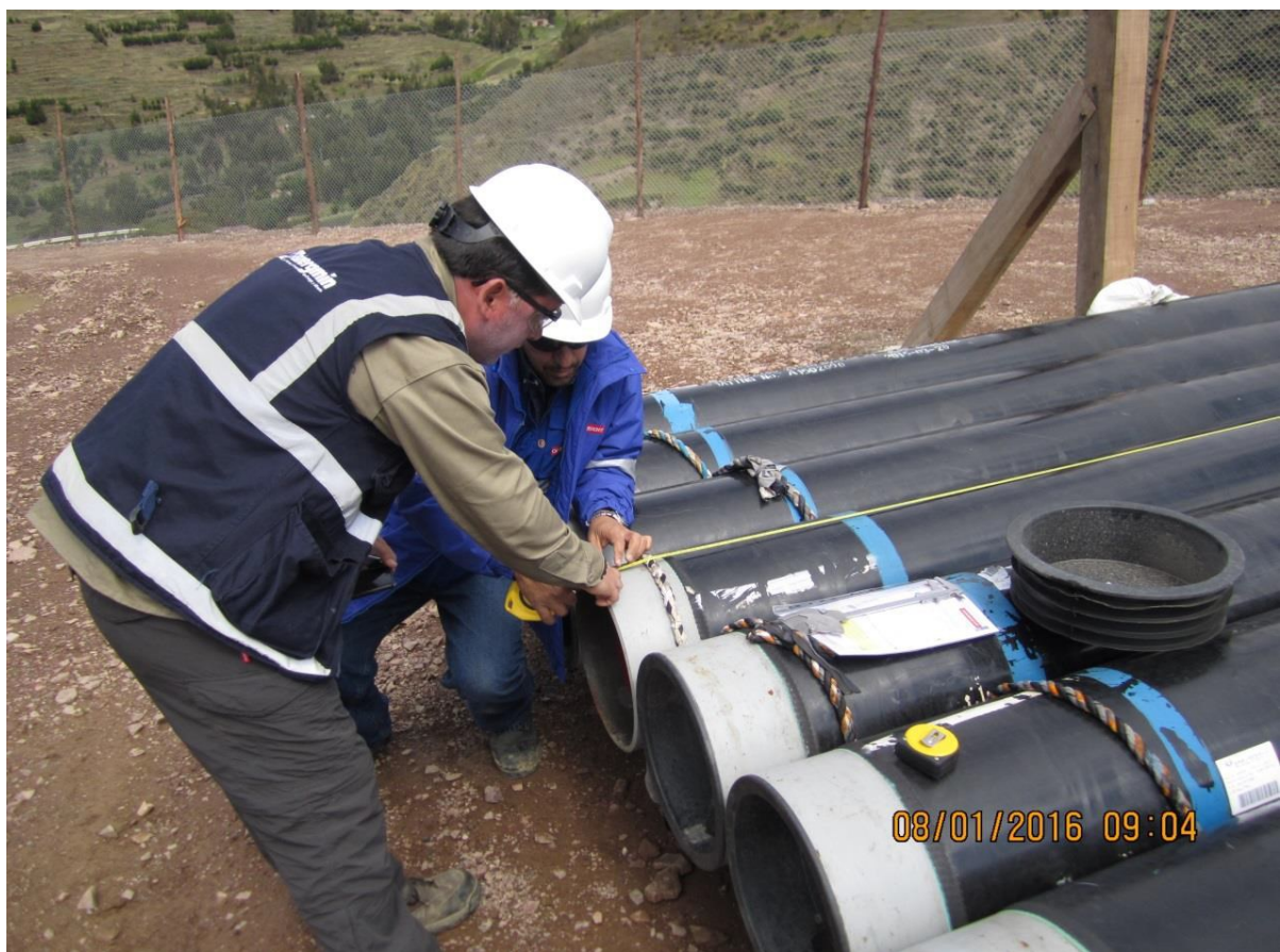
Acopio Pampallacta: Supervisión de la longitud de la tubería.
