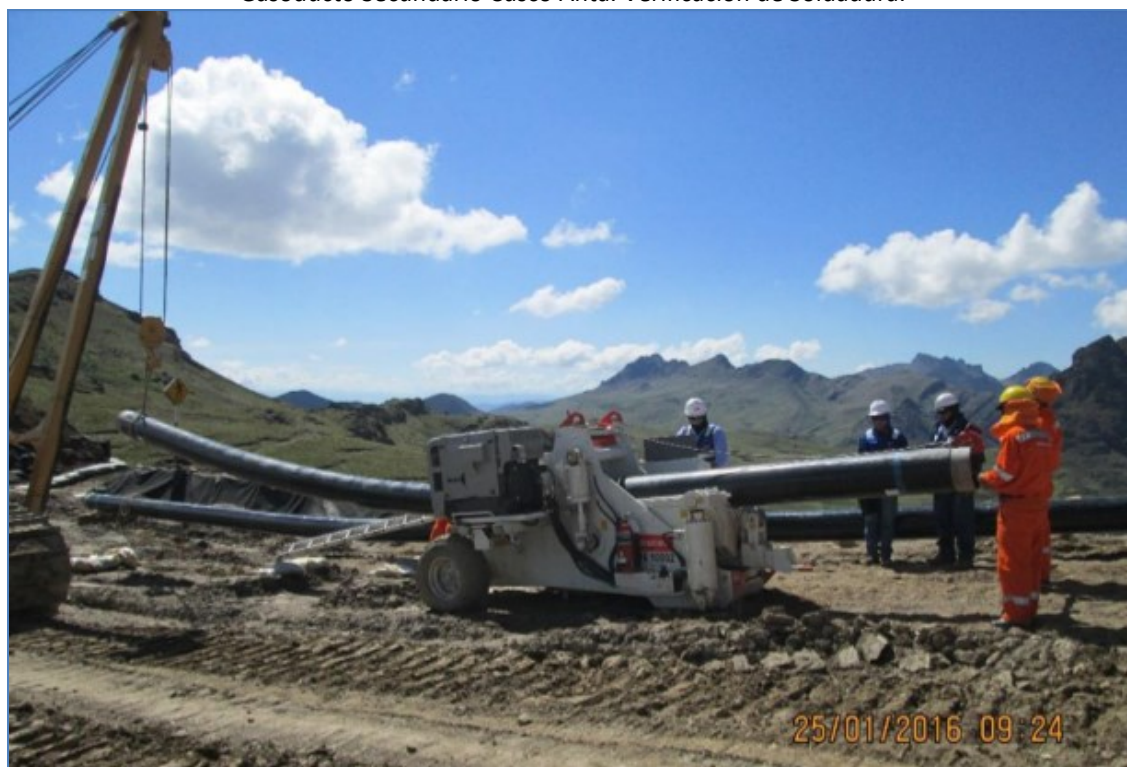
Gasoducto Secundario Cusco. Verificación del doblado de tubo.
