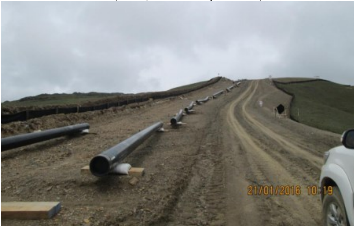
Gasoducto Secundario Cusco Anta (KP 5+400) Desfile de tuberías en el DdV.
