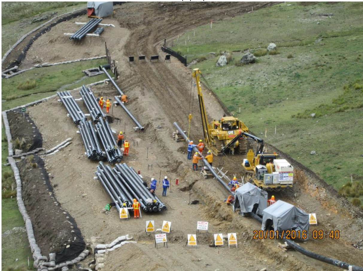
Gasoducto Secundario Cusco Anta. (KP 0+810) Vista panorámica del frente de Soldadura
