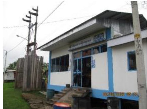
Casa de máquinas
