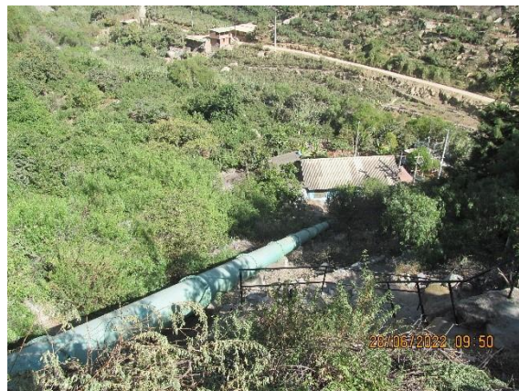
Casa de máquinas
