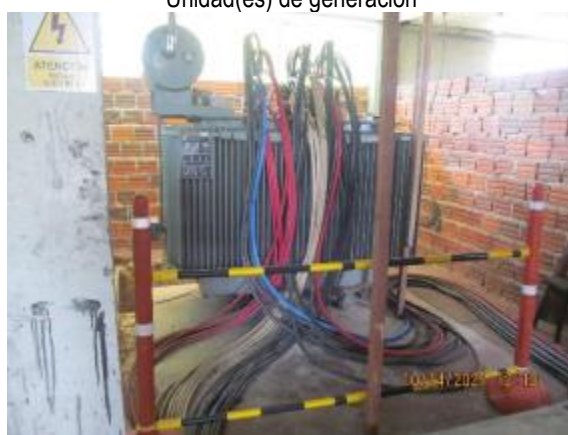
Obras civiles/ Otros componentes
