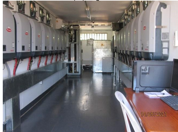
Obras civiles/ Otros componentes
