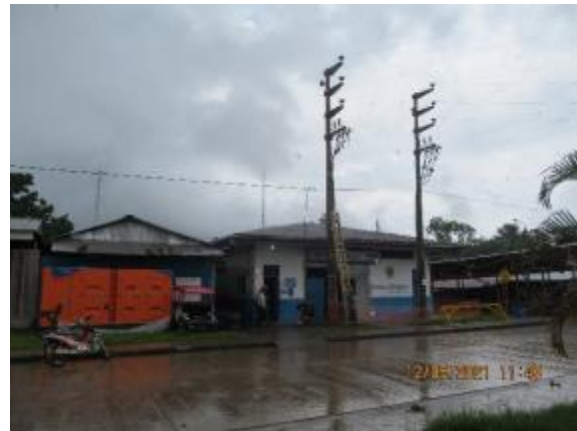
Casa de máquinas
