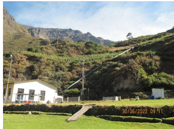
Casa de máquinas
