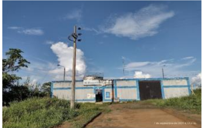
Casa de máquinas
