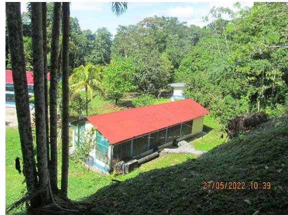
Casa de máquinas
