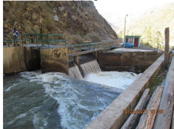
Obras civiles/ Otros componentes
