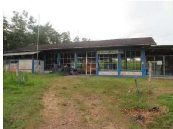
Casa de máquinas
