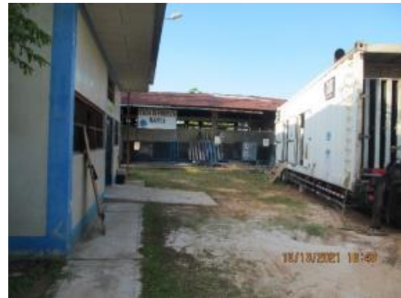
Casa de máquinas
