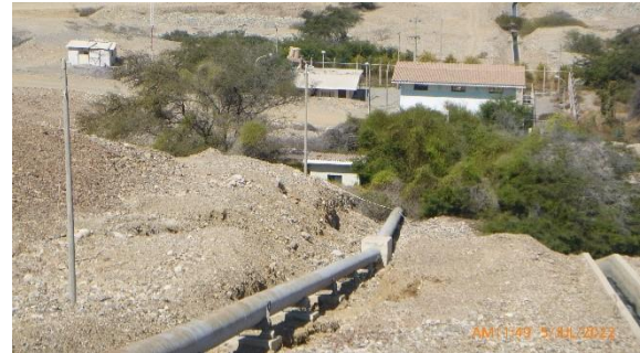
Casa de máquinas
