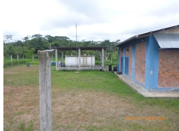
Obras civiles/ Otros componentes
