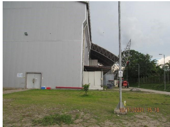
Casa de máquinas
