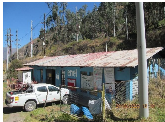
Casa de máquinas
