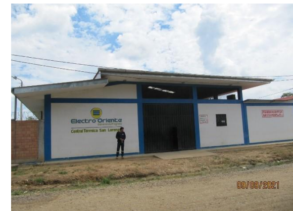
Casa de máquinas
