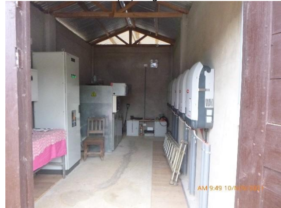
Obras civiles/ Otros componentes
