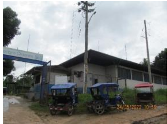
Casa de máquinas
