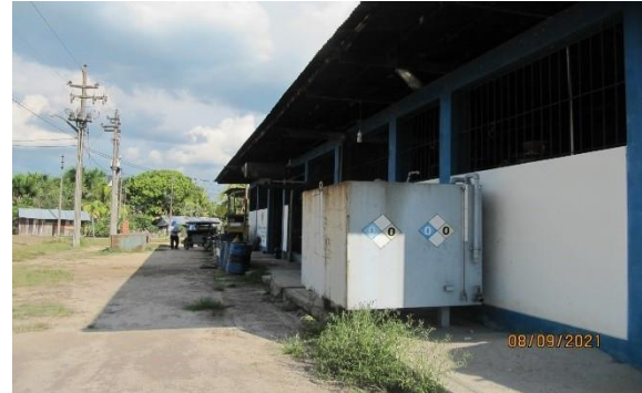
Casa de máquinas
