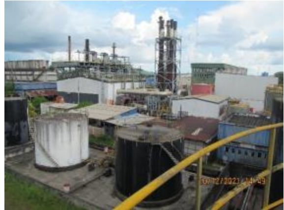
Casa de máquinas
