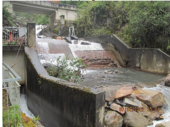
Obras civiles/ Otros componentes
