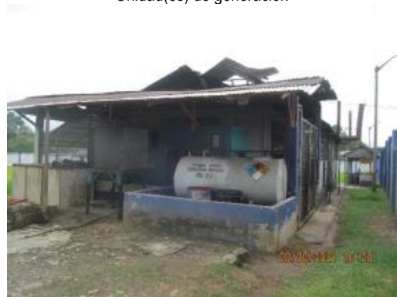
Obras civiles/ Otros componentes
