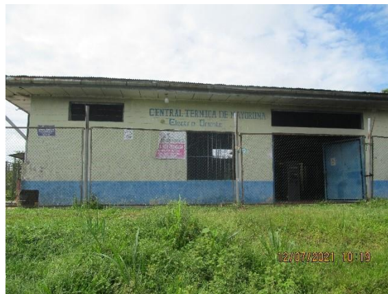
Casa de máquinas
