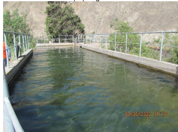
Obras civiles/ Otros componentes
