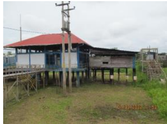
Casa de máquinas
