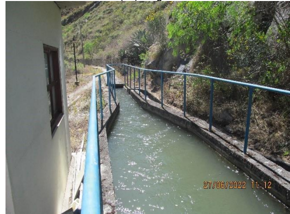
Obras civiles/ Otros componentes
