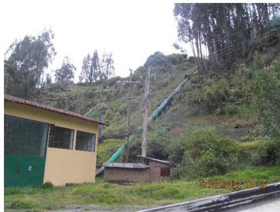
Casa de máquinas
