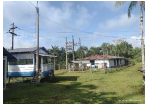
Casa de máquinas
