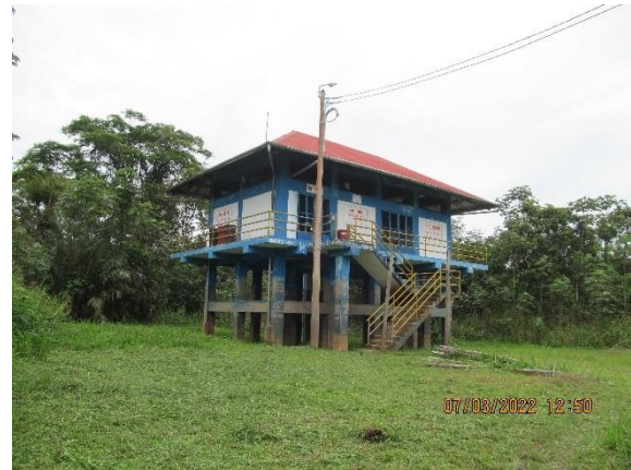
Casa de máquinas
