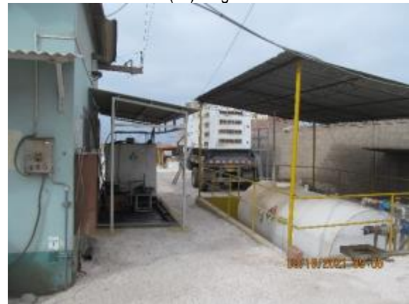
Obras civiles/ Otros componentes
