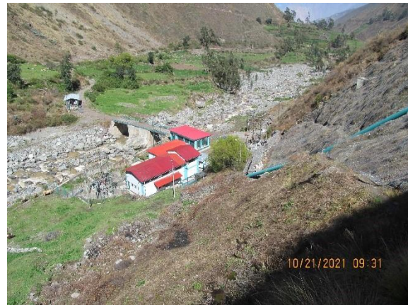
Casa de máquinas
