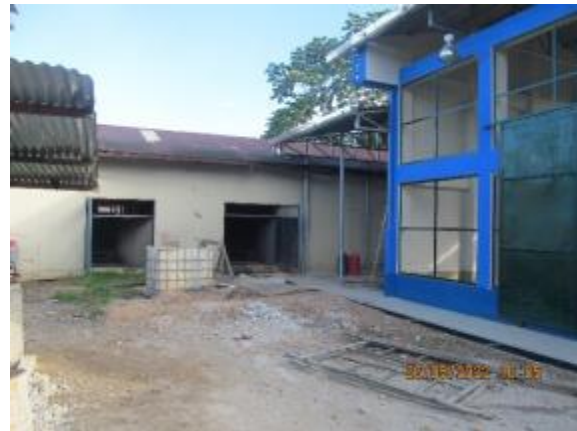
Casa de máquinas
