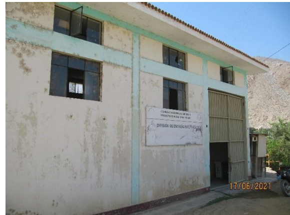
Casa de máquinas
