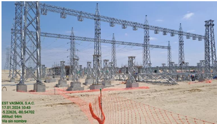
S.E. Miguel Grau, fundaciones, soportes metalicos y pórticos
