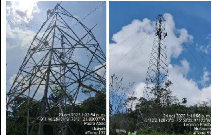
Montaje de torres
