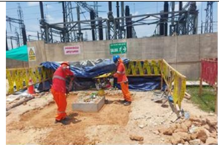
Avance de obras en la S.E. Aguaytía
