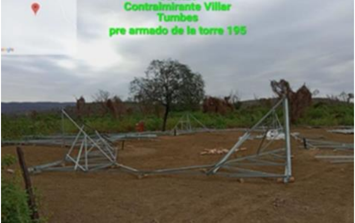
Pre armado de estructuras
