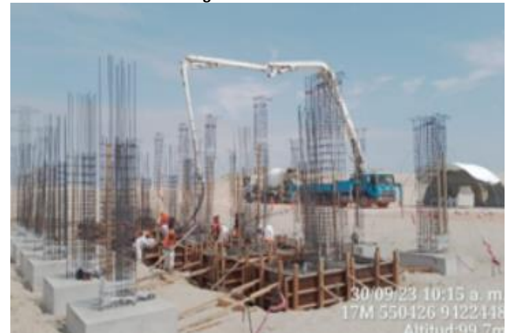
Encofrado y Vaciado de concreto en zapatas del Edificio S.E. Miguel Grau (Piura Nueva)
