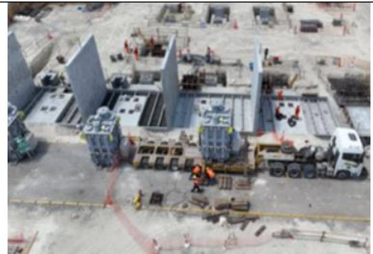
Llegada de reactores a obra
