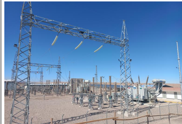
Ampliación de la S.E. Rubí
