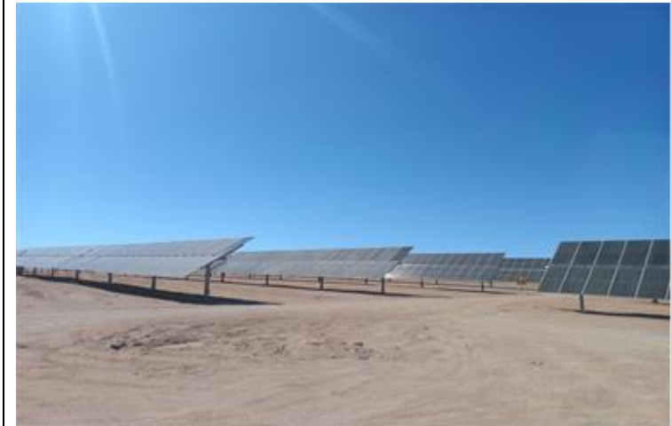
Vista de montaje de módulos fotovoltaicos bifaciales (modelo JKM535M-72HL4-BDVP)
