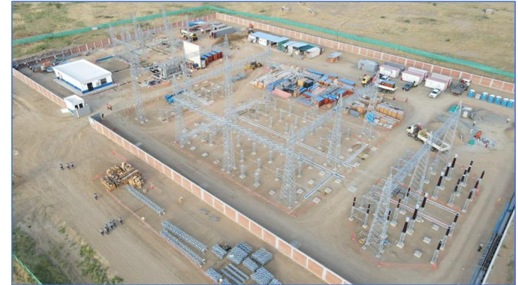
Vista panorámica del avance de obras en la S.E. Valle del Chira
