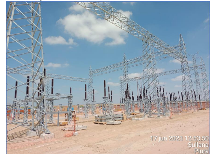
Montaje de equipos de 220 kV
