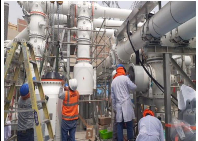
Montaje del último transformador de tensión en la GIS 500 kV
