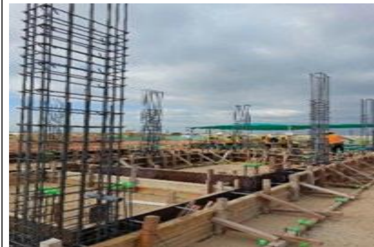
Obras civiles del edificio de control
