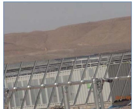
Instalación de seguidores de un solo eje +/- 45°
