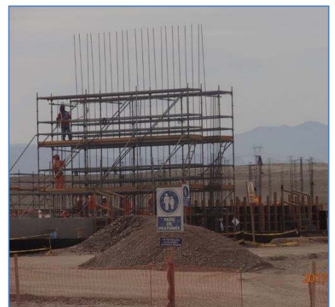
Obras civiles en la S.E. Rubí
