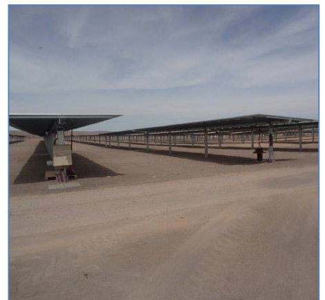
Instalación de estructuras y paneles solares
