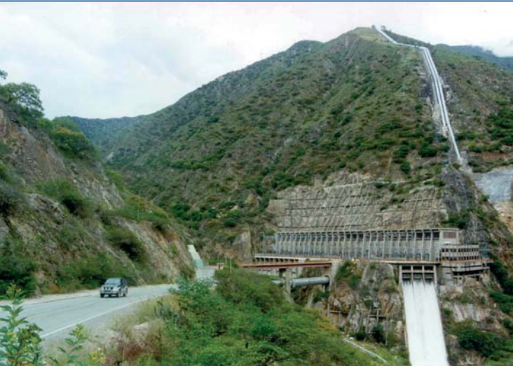
Central Hidroeléctrica Santiago Antúnez de Mayolo.
