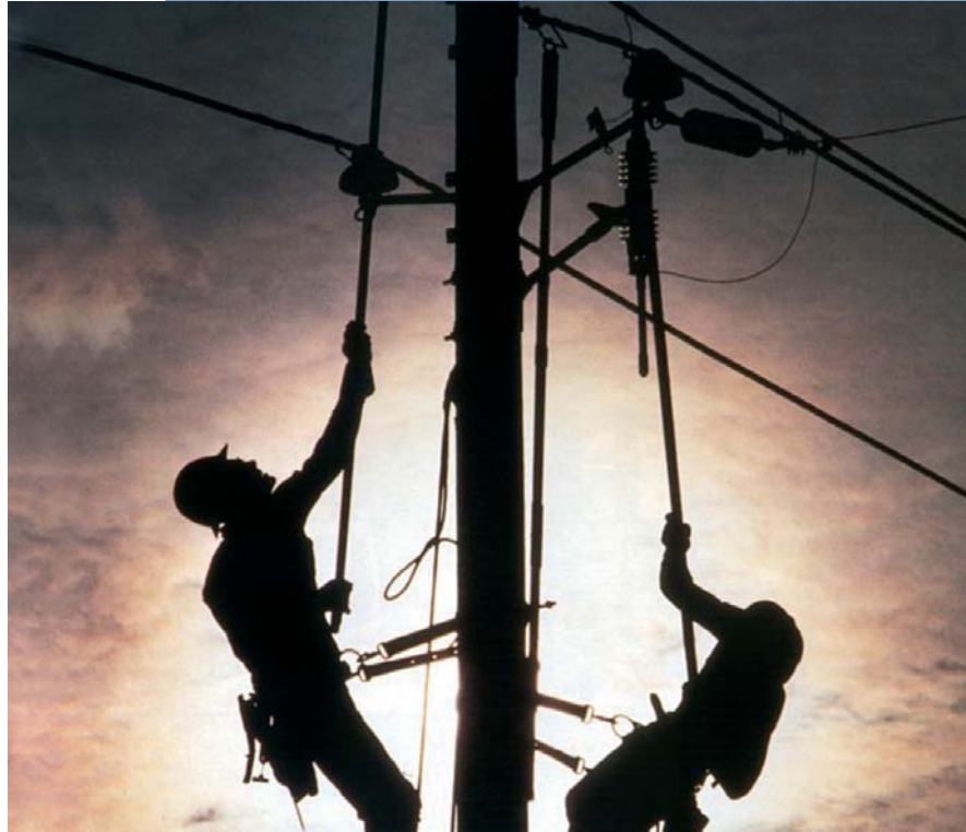
Trabajo de mantenimiento en líneas eléctricas.
