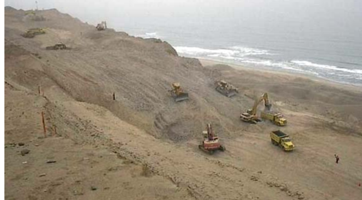
Trabajos de movimiento de tierra del Proyecto de GNL de Pampa Melchorita.
