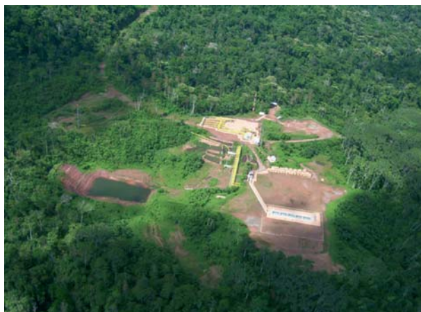
Pozos de producción de gas natural, San Martín 1, Cusco.
