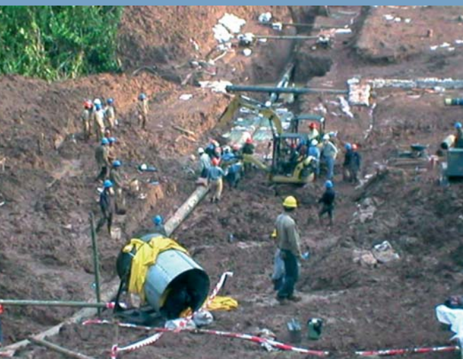
Trabajos de reparación en zona de rotura del ducto en KP 8+800-Malvinas
