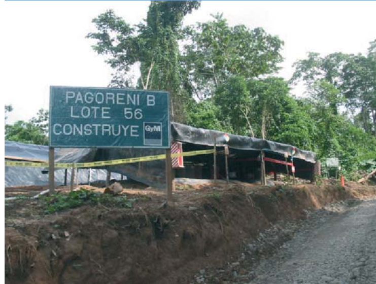
Construcción de la plataforma de perforación en la locación Pagoreni B del lote 56, Cusco.
