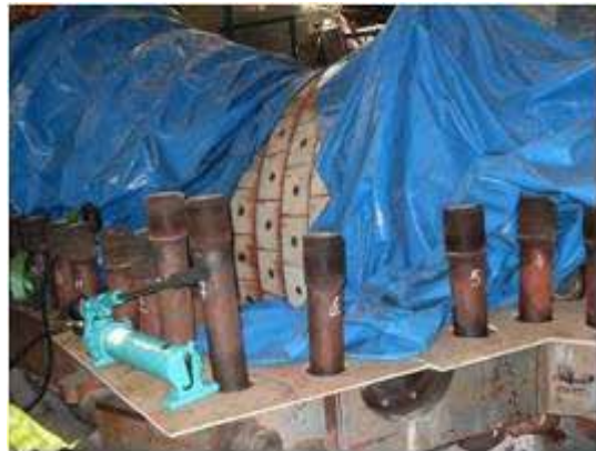
Vista de la parte inferior de la cámara de combustión de la unidad TG4
