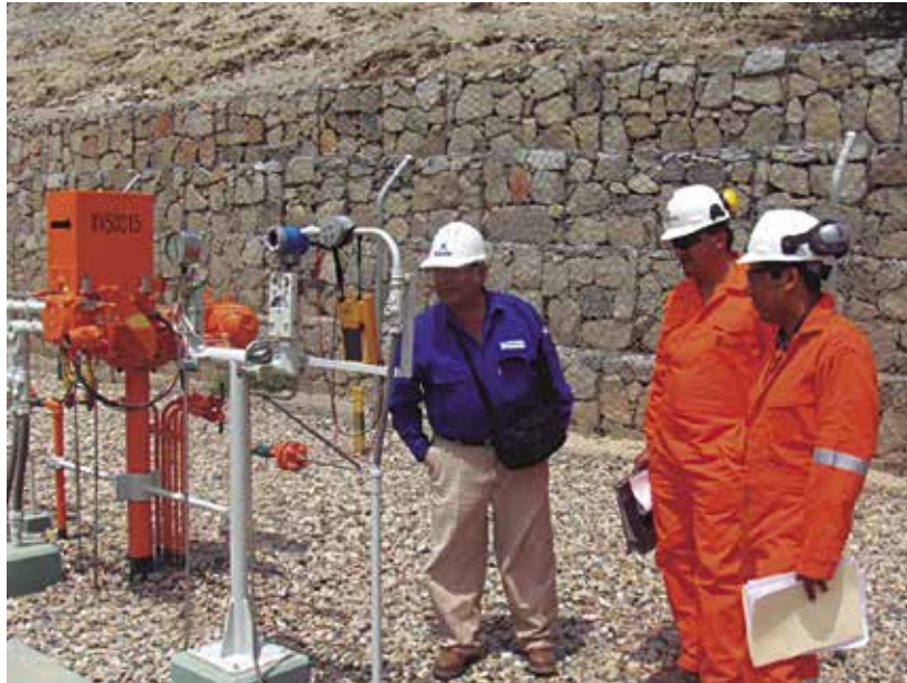
Supervisando y verificando cumplimiento del procedimiento en TGP.
