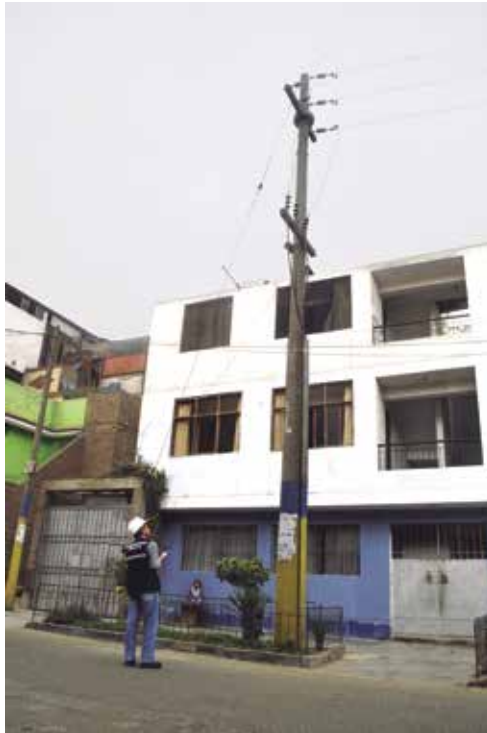
Supervisión del riesgo eléctrico en la vía pública.
