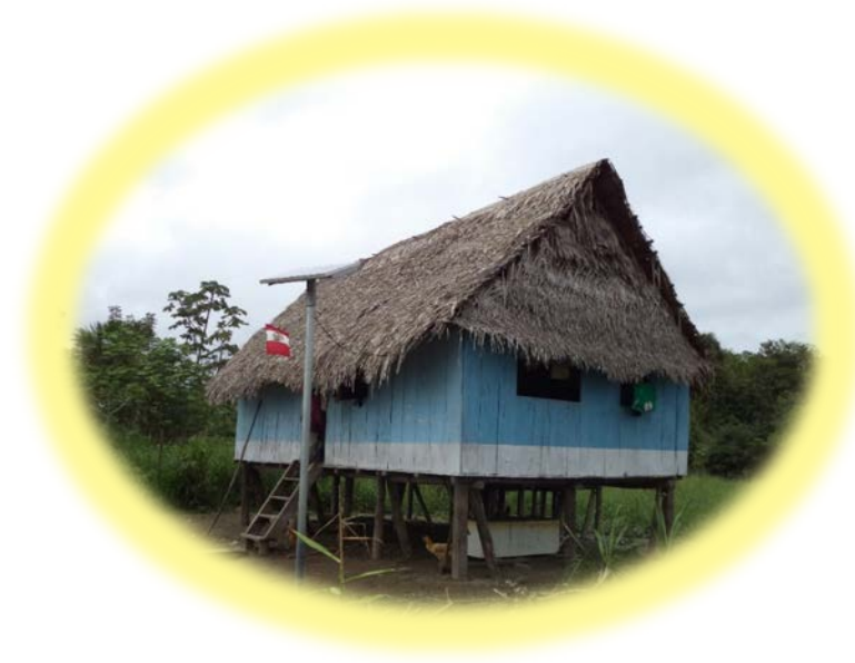
INSTALACIONES RER AUTÓNOMAS
