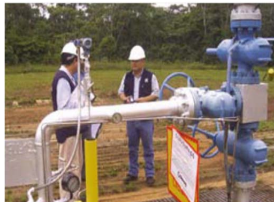
Figura N° 10: Cierre del pozo CN13 ubicado en Lote 1AB
