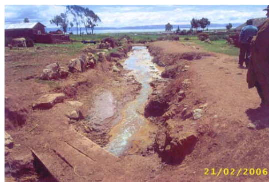
Figura N° 4: Pozo RH10, Aguallane-Puno, vista del canal construido por comuneros para encausar el efluente de agua
