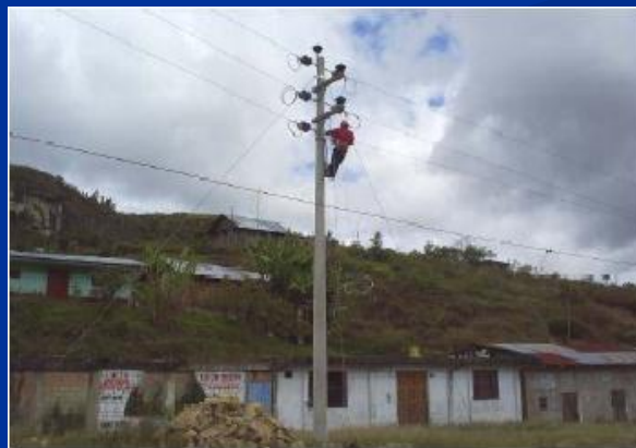
Montaje red Primaria en localidad de Vilcaniza Electrificación Amazonas Sector I Provincia de Bongará, Departamento de Amazonas
