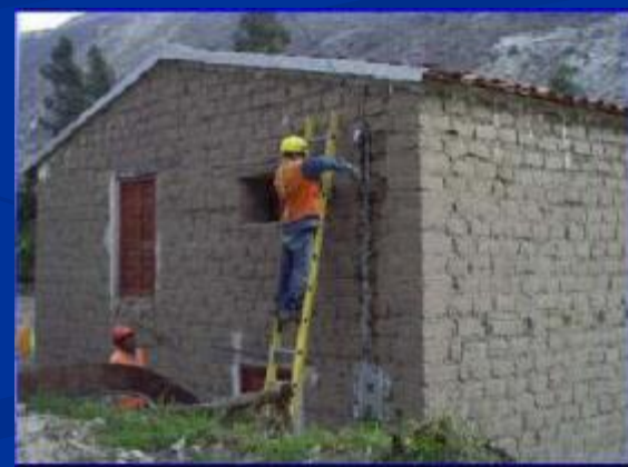
Montaje conexión domiciliaria Localidad Toclla Electrificación Ancash Sector I Provincia de Huaraz y Departamento de Ancash
