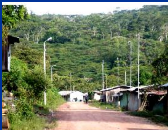
Acomelidas domiciliarias en localidad de Verdecocha PSE Villa Rica II Etapa Provincia de Chanchamayo, Departamento de Junín
